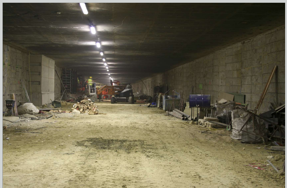
↑ Een deel van de spoorwegtunnel werd reeds gegraven.
