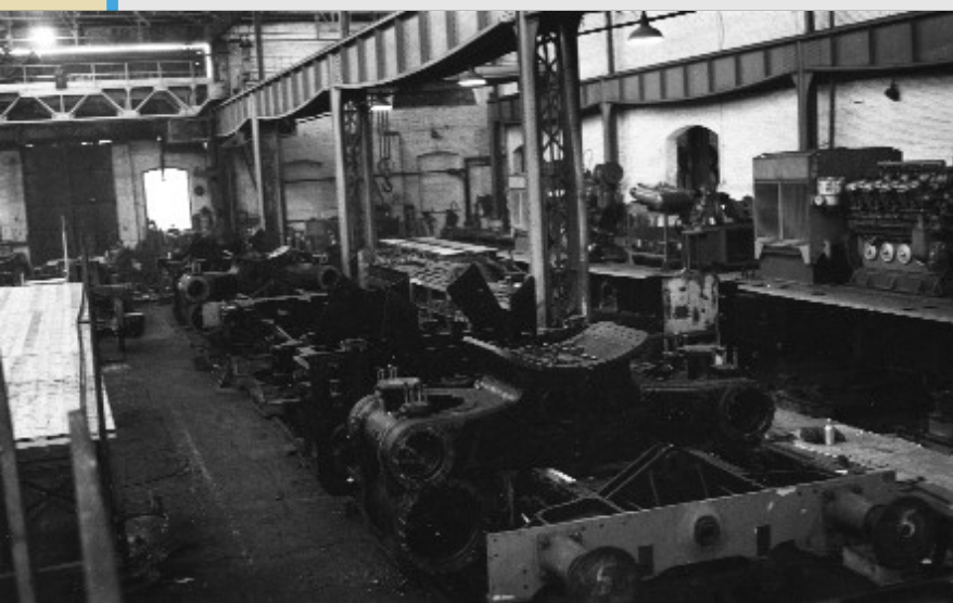
De constructie van de 1D1 type WG voor de Indische spoorwegen. Hierboven de WG-8502.
