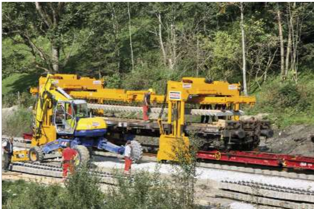
Voor het afladen van de betonnen dwarsliggers wordt gebruik gemaakt van een portiek dat de dwarsliggers onmiddellijk op de bedding legt. De foto werd op 22 september 2009 tussen Mittersill en Rettenbach genomen. Walter PINET.
