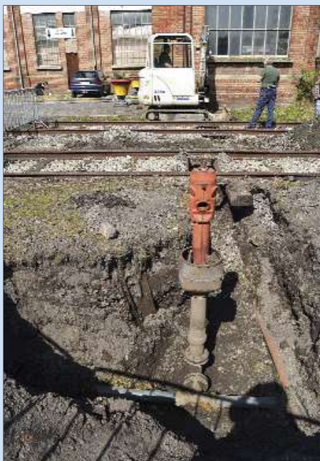
Plaatsing van de nieuwe waterleiding in het Musée du Rail. TSP.
