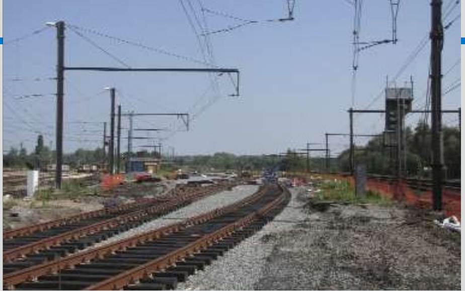
Het nieuwe geheel van zes sporen in aanbouw, bij het verlaten van Mons, naast lijn 96 naar Brussel. Baudouin DIEU.
