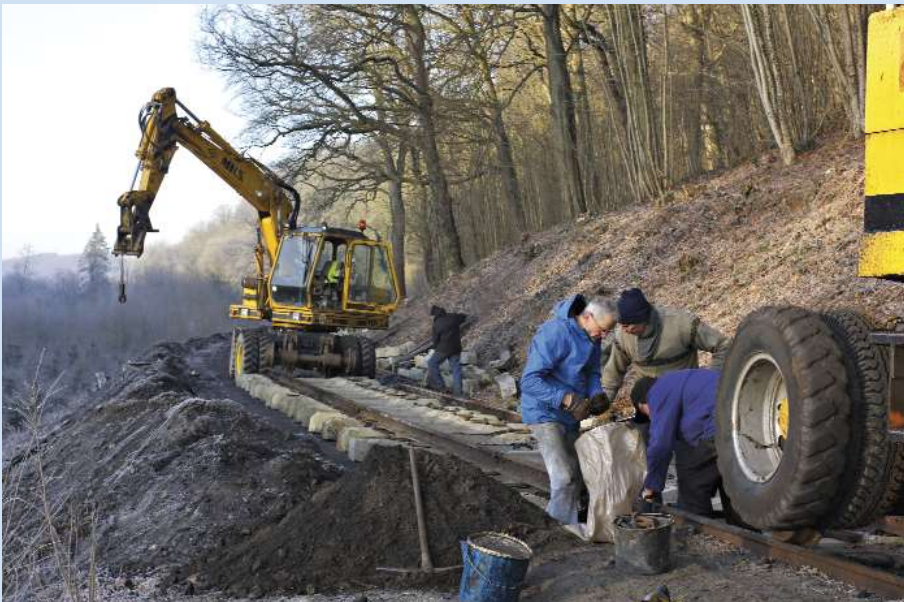
Twee foto's van de werken aan de bochten van Livottes. De eerste 130 m werden op één werkdag vervangen. TSP-CFB.
