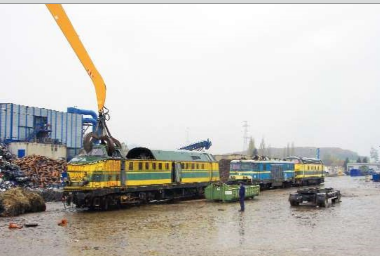
FOTO 108-15 ↑ - FOTO 108-16 ↗ De grijper heeft slechts enkele seconden nodig om de stuurpost af te rukken.
