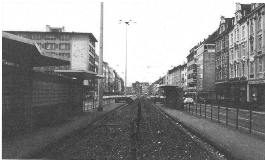
Een somber beeld illustreert een onbegrijpelijke beslissing : niet zo lang geleden was hier een uitstekend gestructureerd trambedrijf actief. Let op de opvallend goede haltevoorzieningen : perrons, perronbeveiligingen, wachthuisjes, onderdoorgangen op het einde van de opstapplaats (die de reizigers toelieten veilig aan de haltes te komen). De bovenleiding is reeds gesloopt, wat overschiet zal weldra volgen ! Foto Bernard Van Craeynest.
