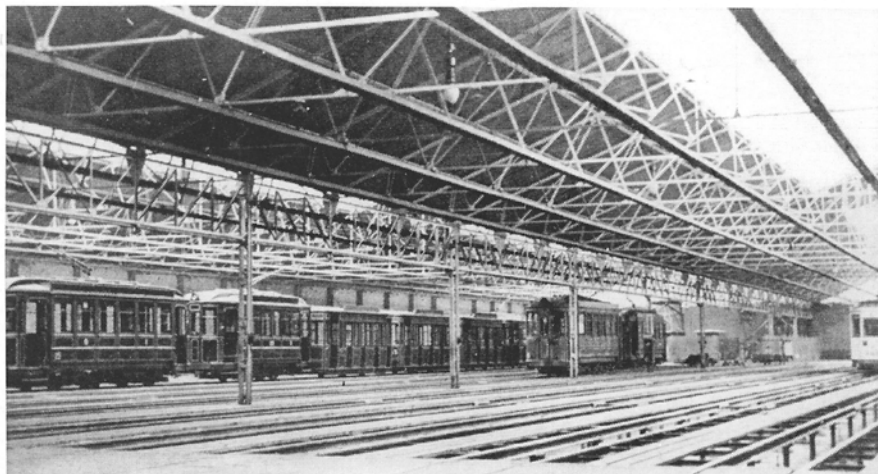
Merksem. Tramloods St.-Bartolomeusstraat, omstreeks 1912. Het linkerdeel van deze remise werd gebruikt voor het onderbrengen van het rollend materieel van Les Vicinaux anversois.
