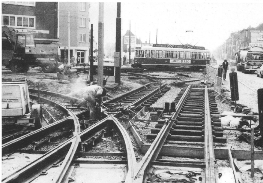
Antwerpen, kruispunt Zwaantjes, zicht richting Hoboken. 5 mei 1988. Aanleg van de nieuwe spoorbaan met vooraan het afbuigend spoor richting De Bruynlaan (keerlus Voetbalstraat). Foto E. Keutgens.
