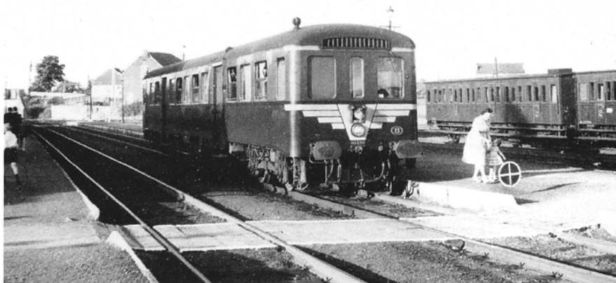
604.03 in oorspronkelijke uitvoering met in het dak ingebouwd verluchtungsrooster. Hier ziet men de achterzijde van het handsein „Spoorovergang”. Rechts een fraai zicht op een tweetal houten drieassige GCI-rijtuigen, voormalige derde klasse. Ramillies, 5 juli 1959. Foto Jacques Bazin, verzameling Jan Mahieu.
