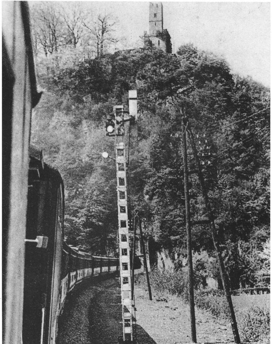
Radiotrein op lijn 36, nabij Nessonvaux/Goffontaine. Foto genomen vanuit de radiopakwagen, die zopas een sein is voorbijgereden (stopsein met drie standen; hier : stand 90°, d.w.z. doorrijden - het volgend stopsein is open). Prentbriefkaart : verzameling Henri van Overschelde.
