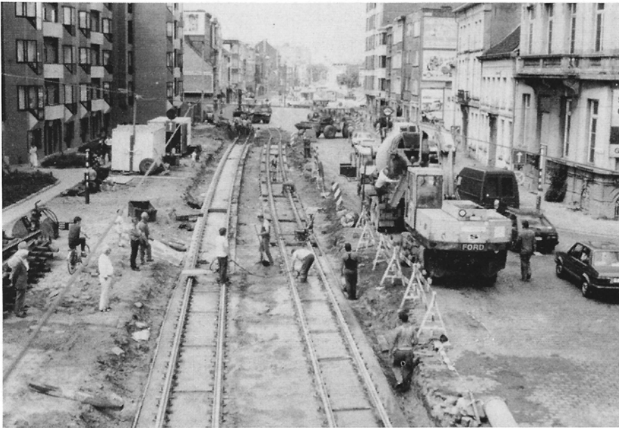
Berchem, Grote Steenweg, zondag 11 juni 1989. Tijdens het weekeinde van 10 en 11 juni werden de nieuwe sporen gelegd en aangesloten ter hoogte van de Oude Kerk van Berchem, tussen de Binnensingel en de Vredestraat. De foto toont ons de werken aan de nieuwe trambedding, zicht richting stad. Foto Eric Keutgens.
