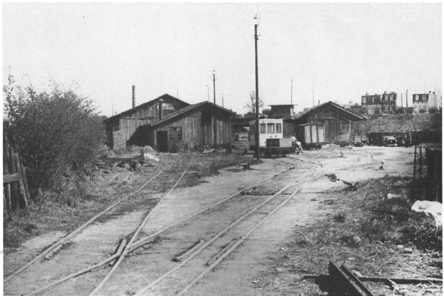
Merksem-IJskelder, 1950. Zicht op de stelplaats richting Ingenieur Menneslaan.
