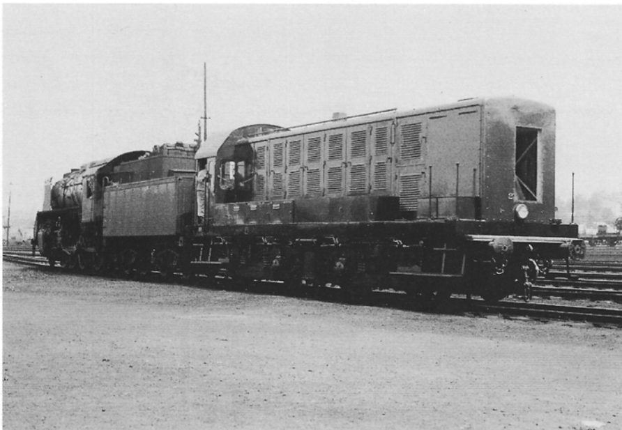
Een stomer van het type 29 sleept „nieuwe aanwinst” 270.003 naar een ander spoor in de bundel. Met het oog op het uitvoeren van proefritten en testen is vooraan een luik uit de kast weggenomen, teneinde de elektrisch aangedreven ventilatorinstallatie te kunnen bereiken. In het voorste gedeelte van de lokomotief, „windkamer” genaamd, bevinden zich ook de koelwaterradiatoren en het oliereservoir van de dieselmotor. Foto NMBS.
