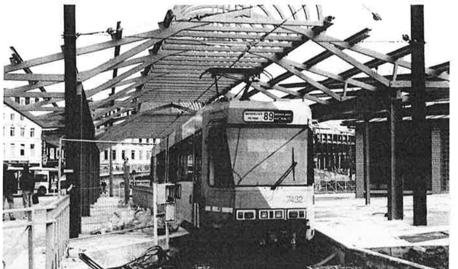
De toekomstige eindhalte in de keerlus te Charleroi Sud. De reizigers zullen links op de tram stappen. Er kunnen trams op een zijspoor in de keerlus worden uitgeweken. 27 februari 1997, foto Alain Janmart.
