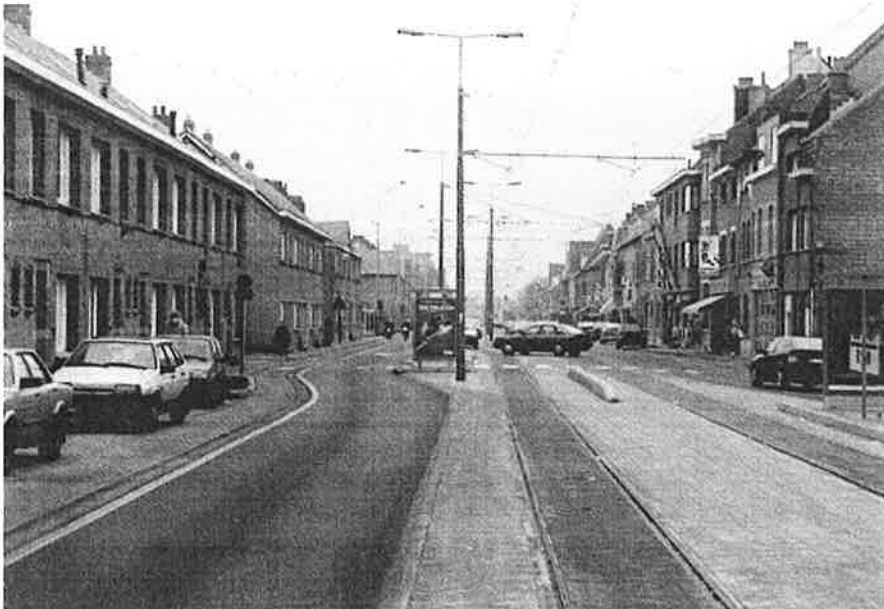
Gent, Zwijnaardsesteenweg, nabij het toekomstig nieuw eindpunt van de te verlengen tramlijn. Over een afstand van ongeveer 1,5 km werden tramsporen, bovenleiding en halteplaatsen aangelegd. Eén ding ontbreekt echter: de tram! 28 januari 1997, foto Alain Janmart.
