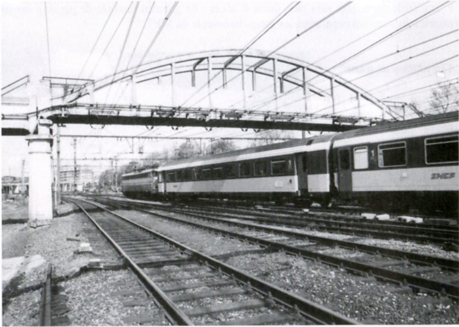
Namur : cisaillement actuel, côté « est » (passerelle d'Herbatte) : le train EC 30 Molière venant de Liège et en direction de Paris-Nord, sort de la ligne 125 et cisaille la 162 (Arlon), avant de cisailer la 154 (Dinant) ; il va être reçu voie 1 (photo M. Lebeau, 5 mai 1966)
