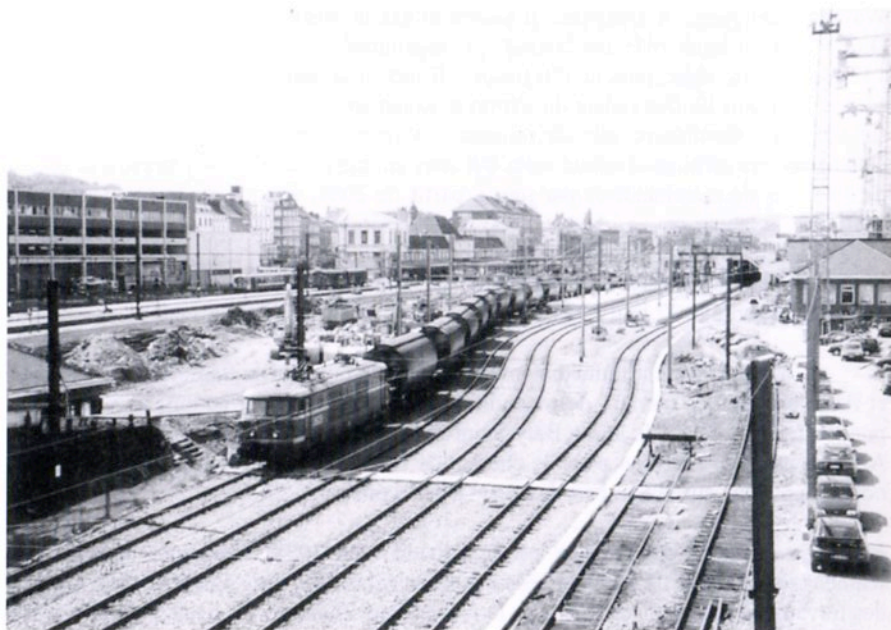
Namur : photo prise du pont de Louvain . De gauche à droite : voies 1 à 3 et latérales « est » en service, zone des voies 4 à 7 totalement démolie et livrée au matériel de génie civil, voies 8 à 11 (nouvelles) en service sous la dalle. Sur la voie 8 circule un train de marchandises remorqué par une locomotive série 26 (photo M. Lebeau - 4 septembre 1997).
