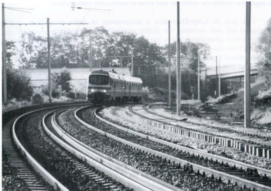
Liège Haut-Pré le 25 août 1997 : vue nord-sud du site de la ligne 36 en cours de modification : le train L 7056 Liège - Waremme (AM 951) longe une des deux nouvelles voies de la courbe (photo M. Lebeau).
