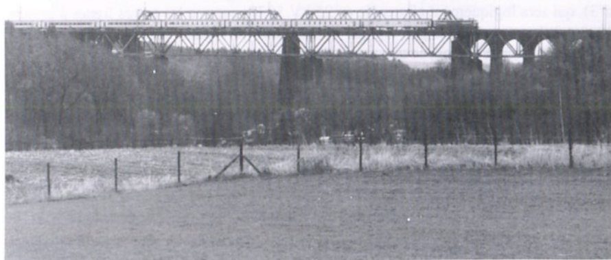
Vue de ce viaduc au passage de l'IC 420 remorqué par une 16 et circulant à contre-voie le samedi 27 décembre 1997 vers Liège et Ostende (photo M. Grieten).
