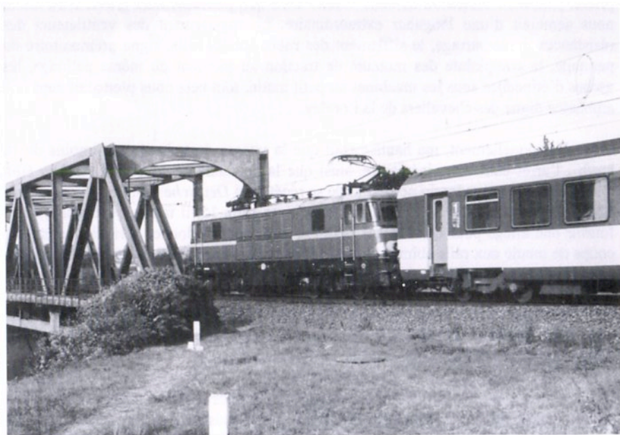
Une vue du passé : locomotive 1504 en tête, le défunt EC 30 « Molière » (rame Corail de la SNCF) franchit le pont-rail sur la Sambre à Floriffoux (ligne 130 Namur - Charleroi) à destination de Paris-Nord (photo M. Lebeau - 2 octobre 1997)
