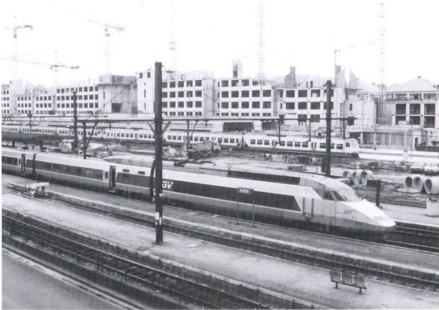
Vue globale du chantier de Namur : à l'avant-plan, voie 1, la rame TGV Réseau SNCF tricourant 4522 assurant les TGV « wallons » 9497 (Paris - Namur) et 9498 (Namur - Paris), au centre l'automotrice Break SNCB de la relation IC Mouscron - Herstal marque l'arrêt voie 8 nouvelle, en arrière-plan le premier tiers de la dalle de couverture et les imposants bâtiments en construction du MET (photo M. Lebeau - 21 janvier 1998)
