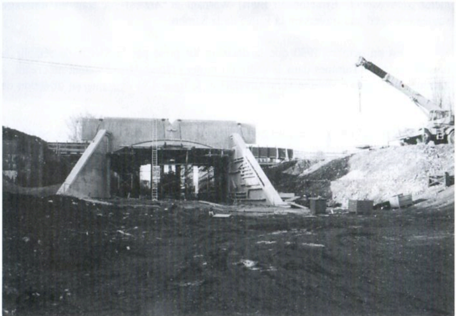
Sur le site en tranchée de l'ancienne gare de Lambusart, un nouveau pont permettra à la route nationale 912 de franchir les voies; la vue de cet ouvrage d'art est prise vers Fleurus le 9 novembre 1997 (photo M. Grieten).
