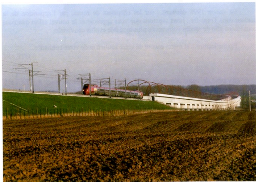
Deux vues de la LGV belge n°1, prises par M. Lebeau le 8 janvier 1998 : ↑ Saintes (BK 19) : une rame PBA file vers la tranchée couverte de Tubize. ↓ Arbre (BK 50) : le TGV Thalys (rame PBKA) 9324 file vers Paris-Nord ; en arrière-plan, le plus long viaduc ferroviaire d'Europe.
