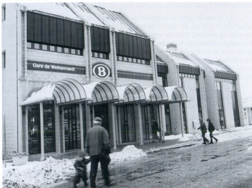
Le nouveau bâtiment de Welkenraedt, côté « ville » (photo SNCB)
