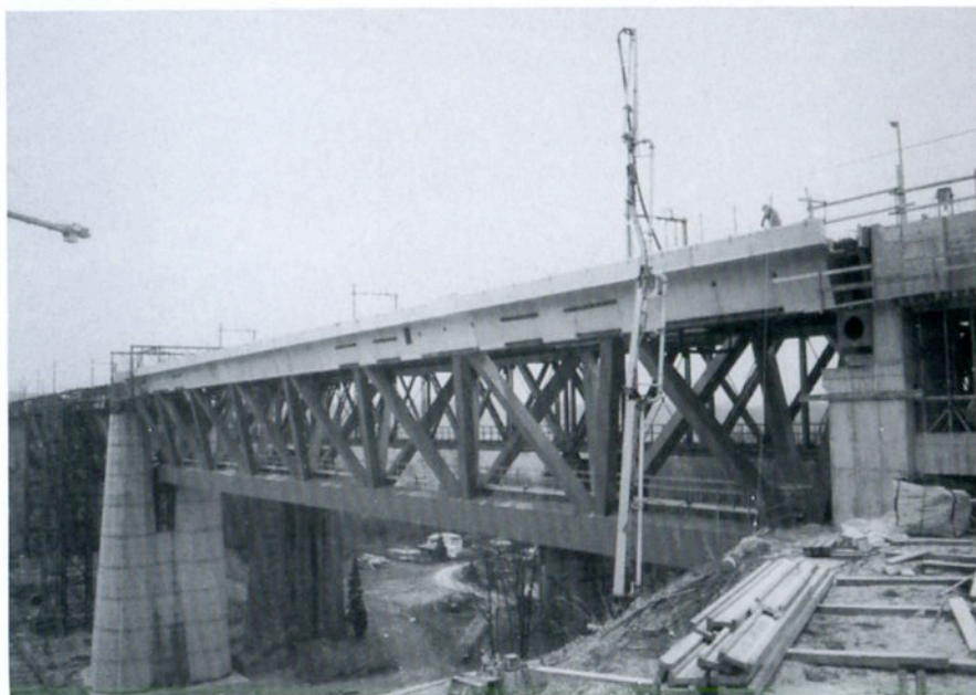
Le viaduc de la Hammerbrücke, vu en direction de Welkenraedt, à la mi-janvier 1999 (photo H. Groteclaes)
