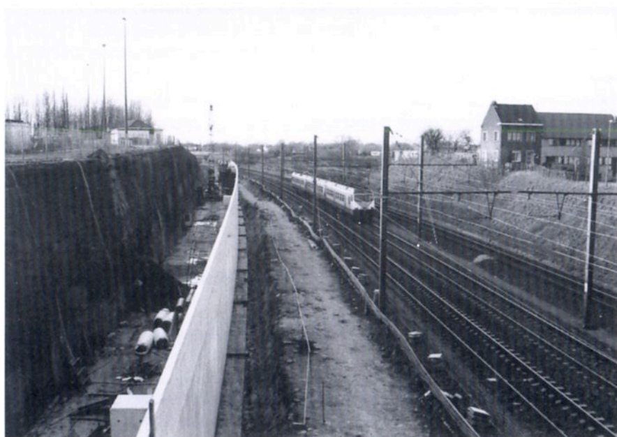
Diegem - pont de la Kosterstraat (photos C. Beghin - janvier 1999)
