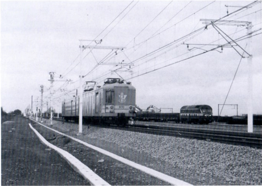
Voroux - nouvelle voie « B » ligne 36 le 4 mars 1999 : l'automotrice postale 970 monte vers Bruxelles (remarquons les nouvelles consoles d'électrification et l'incroyable locomotive diesel 5936 sur la base travaux TGV en construction). Photo M. Grieten - 04.03.99
