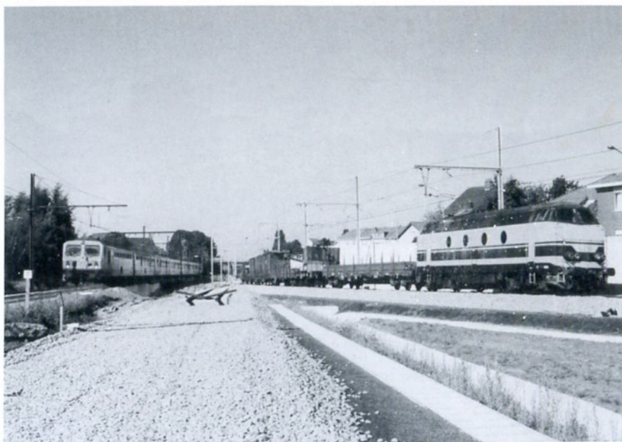
Zaventem : à gauche, train IC F Quiévrain - Liège-Guillemins au passage (6 voitures M4 et 2731 en pouce), au centre, amorce de la 3ème voie vers Louvain, à droite locomotive 6281 et train d'électrification CEI sur la voie A ligne 36C vers l'aéroport à la B.K. 0.045 (photo M. Grieten - 16.09.99)
