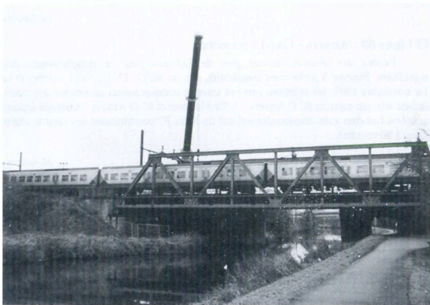
Denderleeuw - travaux au pont sur la Dendre : l'IR La Panne - Schaerbeek au passage sur ligne 50A/2 (photo M. Grieten)
