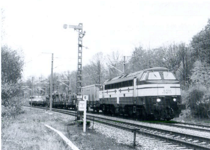
Vendredi 5 novembre 1999 15h30, fin de la semaine de travail pour le train de chantier de la S.C.L.E., encadré par les locomotives 5215 et 5216, photographié à Saint-Vincent-Bellefontaine devant la palette E37 (photo J. Perenon)
