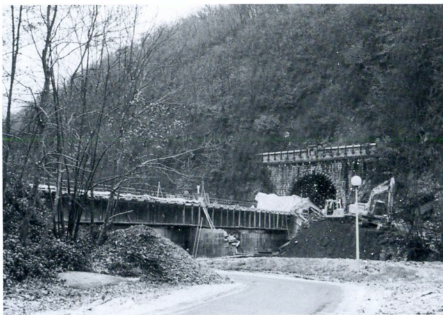
Pont ferroviaire sur la Lesse à Houyet et tunnel en travaux (photo M. Grieten - 22.11.99)
