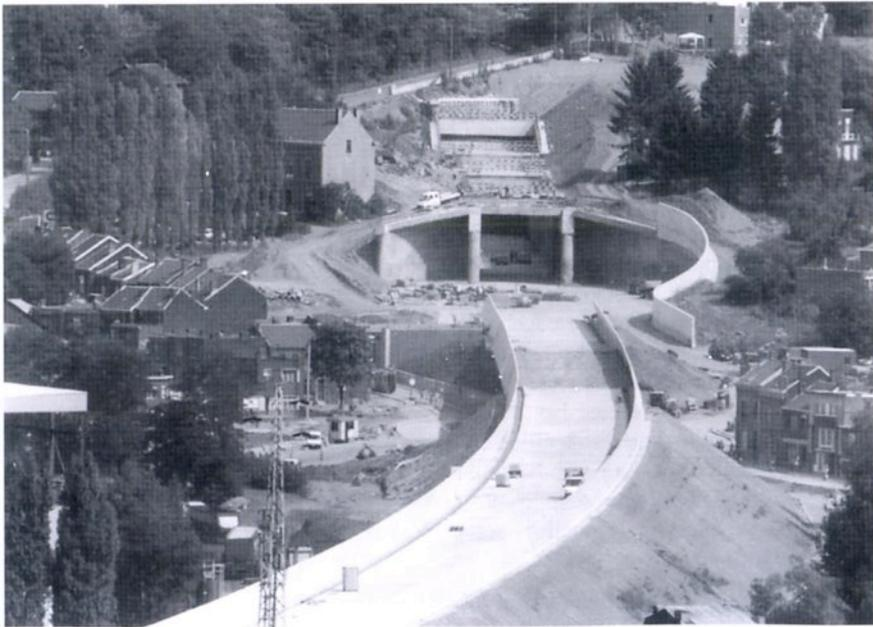
**Zoom sur la tranchée couverte et la plate-forme d'entrée. A droite la cloison courbe et une voie d'accès de service. A gauche, dissimulée dans les talus, la cabine électrique dont le coin arrière s'encastre dans le parapet (sept. 2001)**
