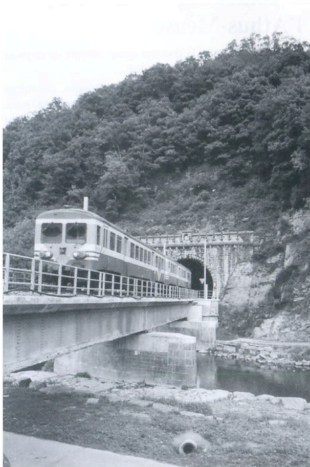
Autorails 4509 et 4407 assurant le train L 6060 Dinant – Libramont à la tête du tunnel de Houyet le 10.08.01 (photo M. Grieten)
