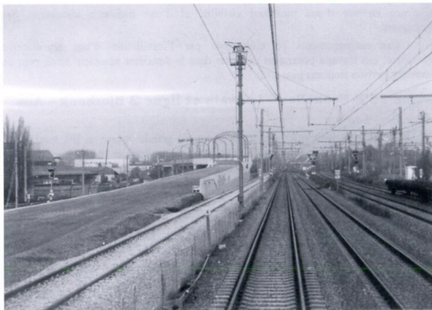
Sortie de Louvain côté Bruxelles : à gauche, assiette de la future ligne 36N rapide vers Bruxelles et amorce du viaduc sur la Dyle (photo GTF asbl – novembre 2001)
