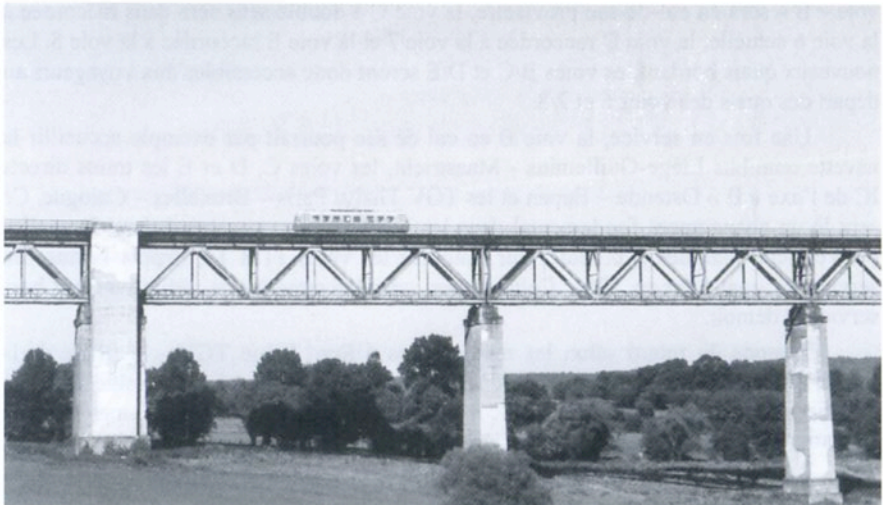
L'autorail 5602 sur le viaduc de Moresnet le 24.09.00 (photo M. Grieten)
