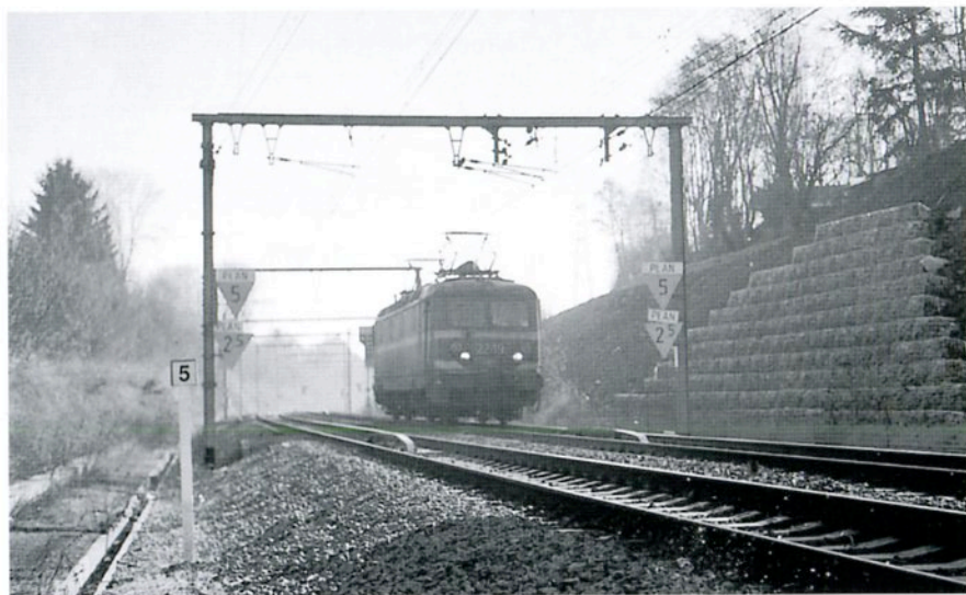
Une « allège décollée » (locomotive électrique 2249) termine de gravir les plans et arrive à Ans le 18.02.05 (photo J. Evrard)
