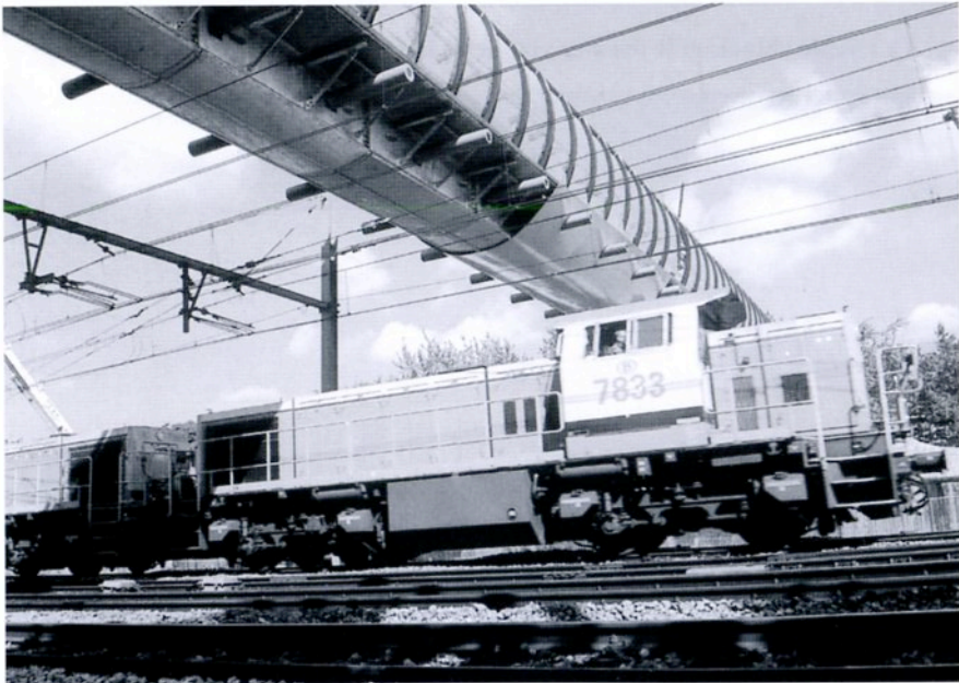
La nouvelle passerelle, vue de bas en haut, du trottoir du boulevard Cauchy, tandis que la locomotive diesel 7833 roule sur la ligne 125 provisoire (02.09.05 – photo . Lebeau)
