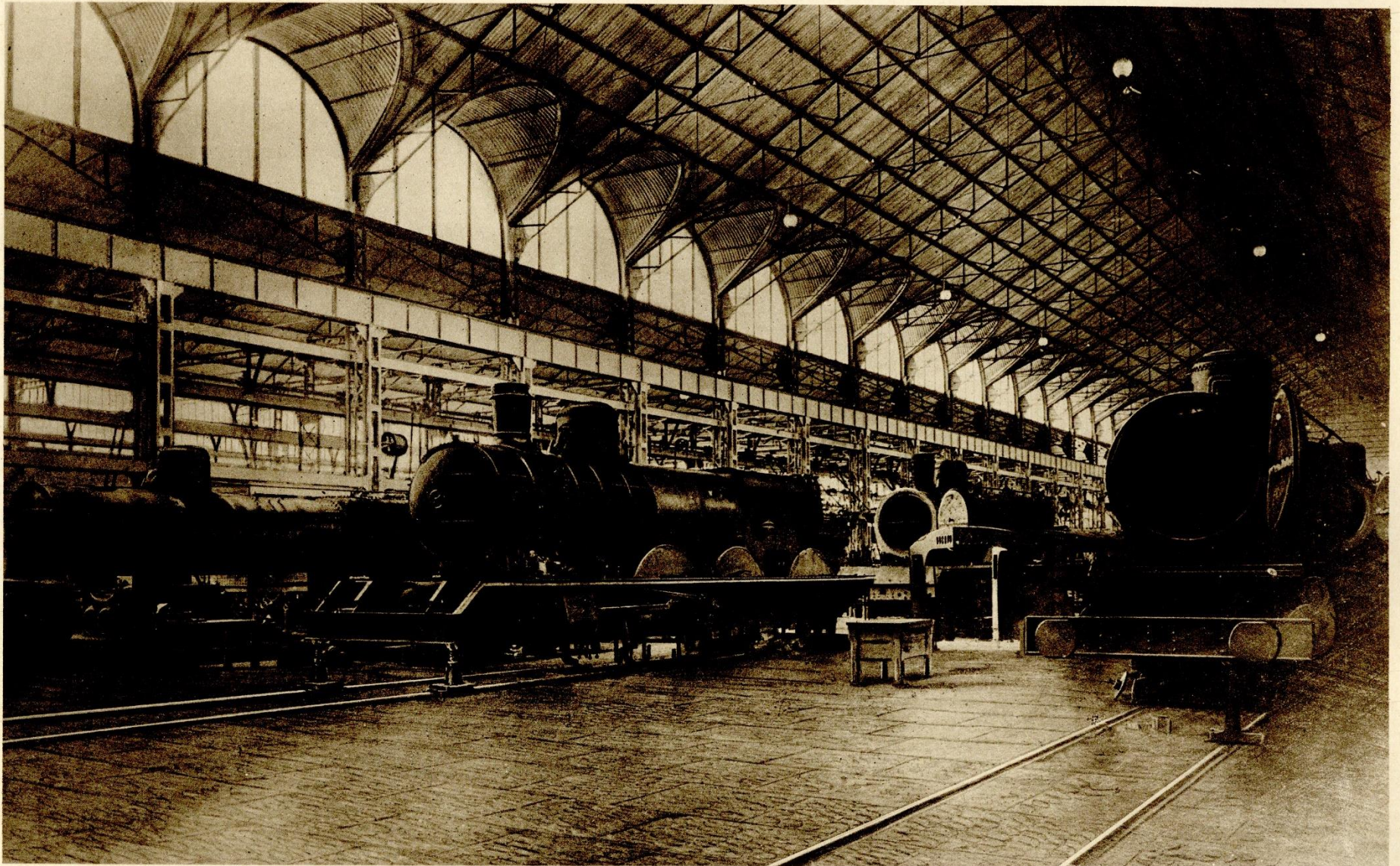
PARTIE D'UNE HALLE DE MONTAGE DE LOCOMOTIVES.
