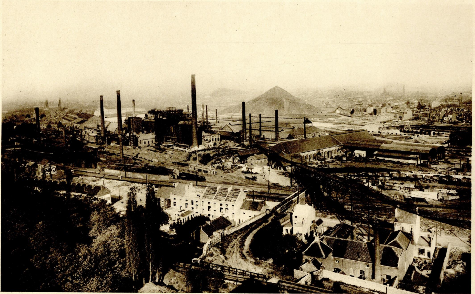
VUE GÉNÉRALE DE L'USINE.
