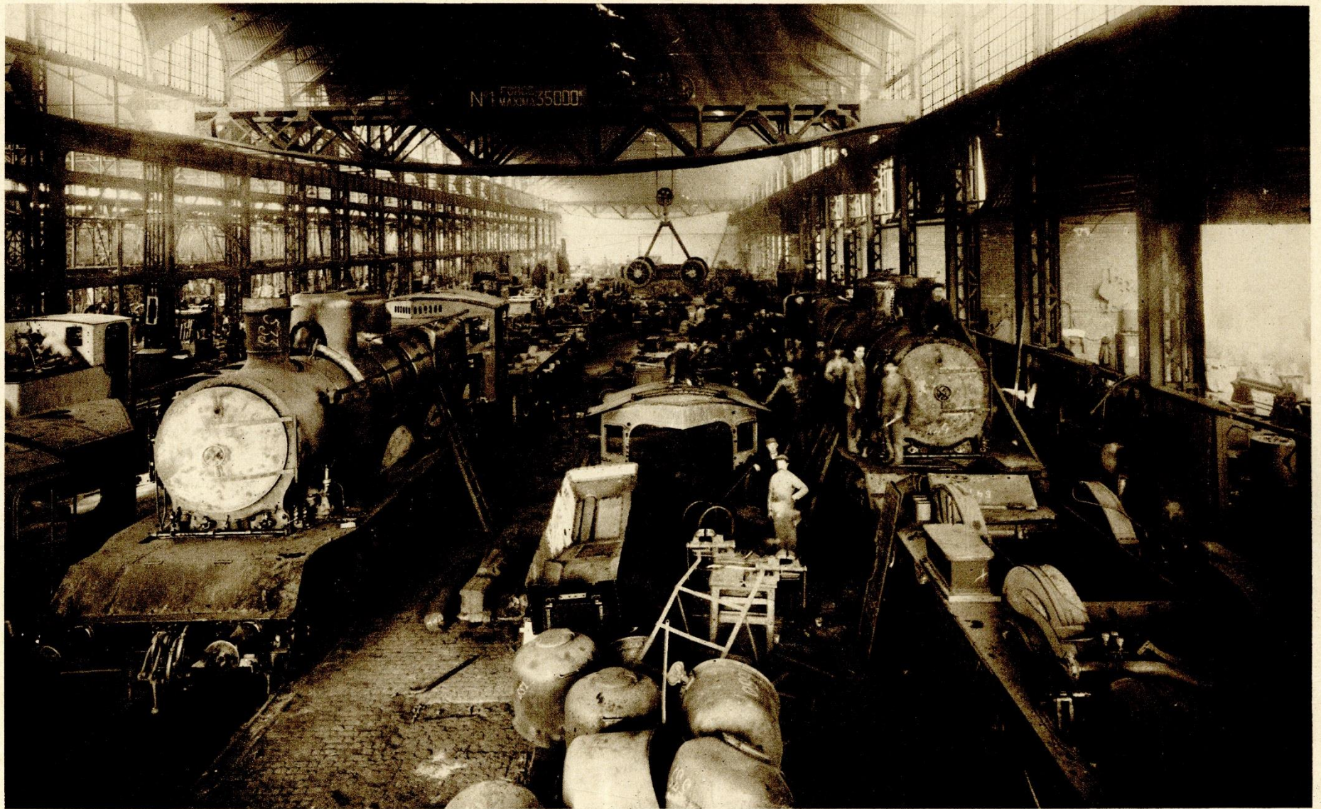
MONTAGE DE LOCOMOTIVES, HALLE N° 2
