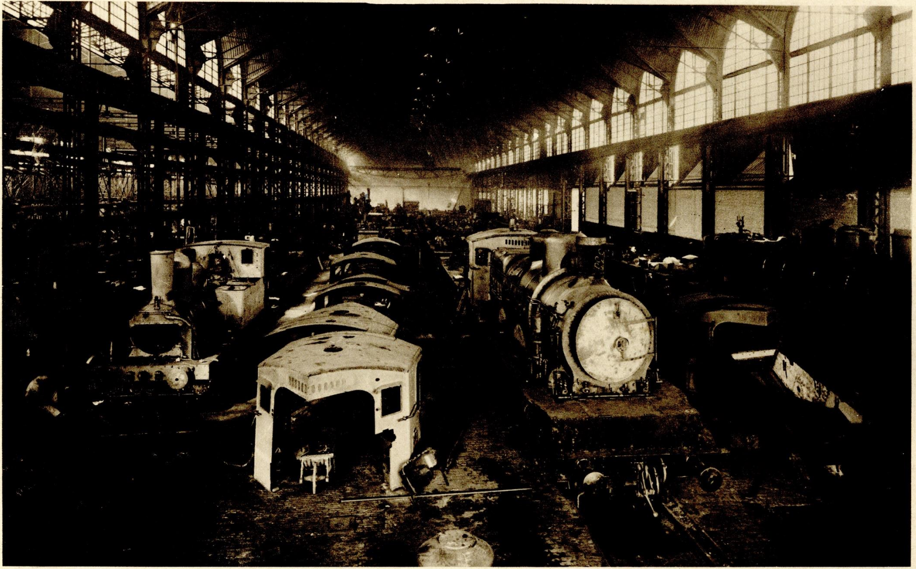
MONTAGE DE LOCOMOTIVES, HALLE N° 1
