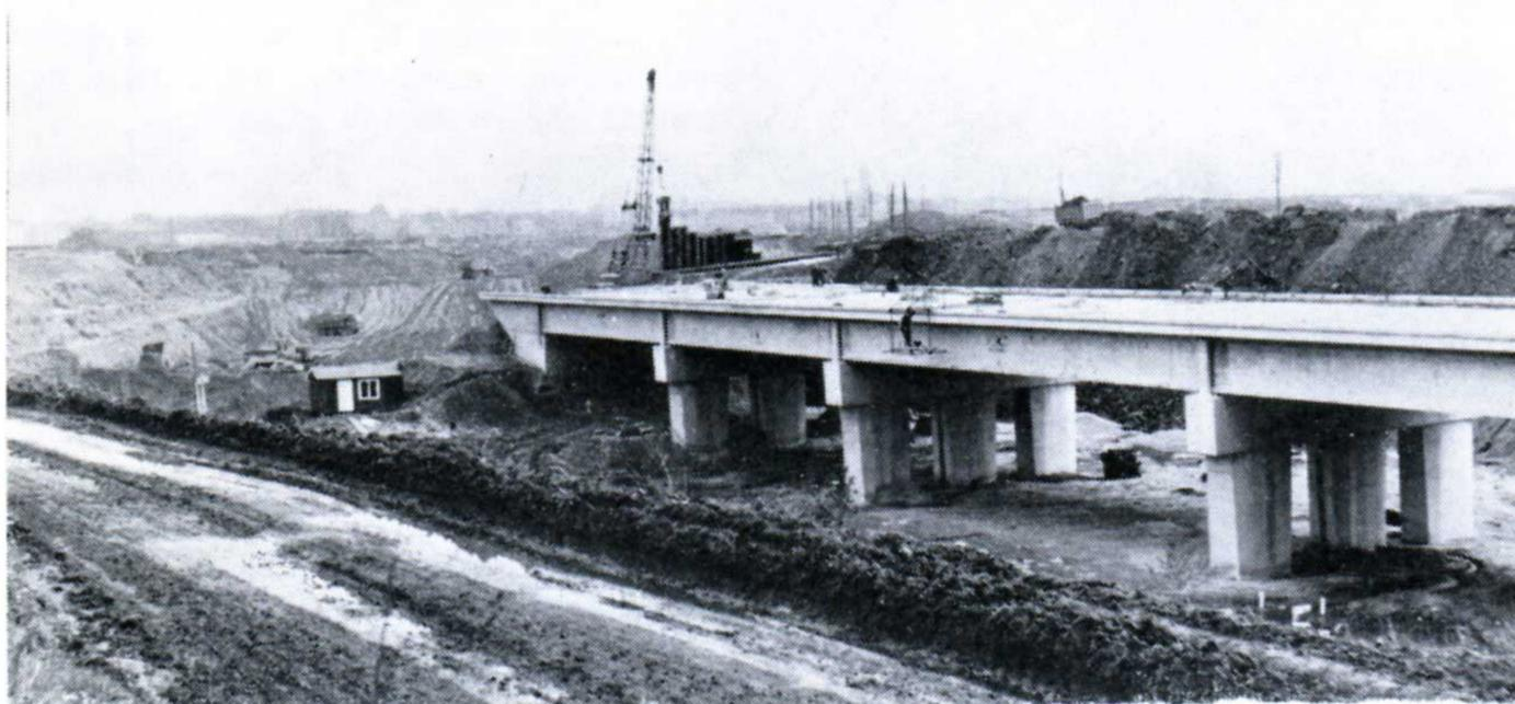
en construction dans une souille sur la rive gauche ; on distingue, de gauche à droite, le pertuis ferroviaire devant recevoir deux voies électrifiées, un pertuis routier à trois bandes, le pertuis pour les piétons et cyclistes, et enfin, partiellement, un deuxième pertuis routier à trois bandes.
