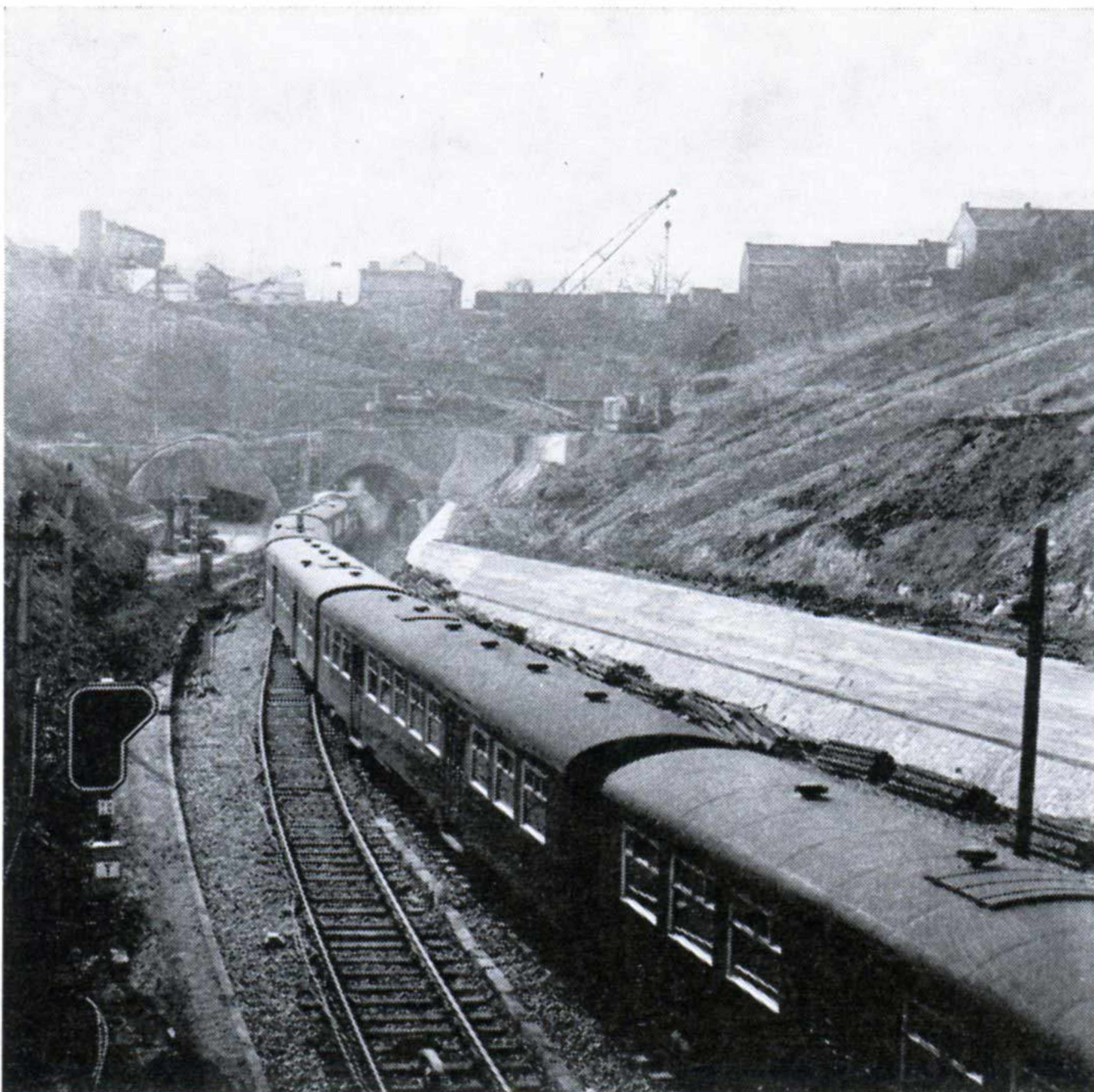
Ci-dessus, état des travaux en mars 1969 avec à gauche le nouveau tunnel et à droite la tête Est de l'ancien; ci-dessous, en juillet 1969, la tête du nouveau tunnel est achevée (photos R. Boddewijn)
