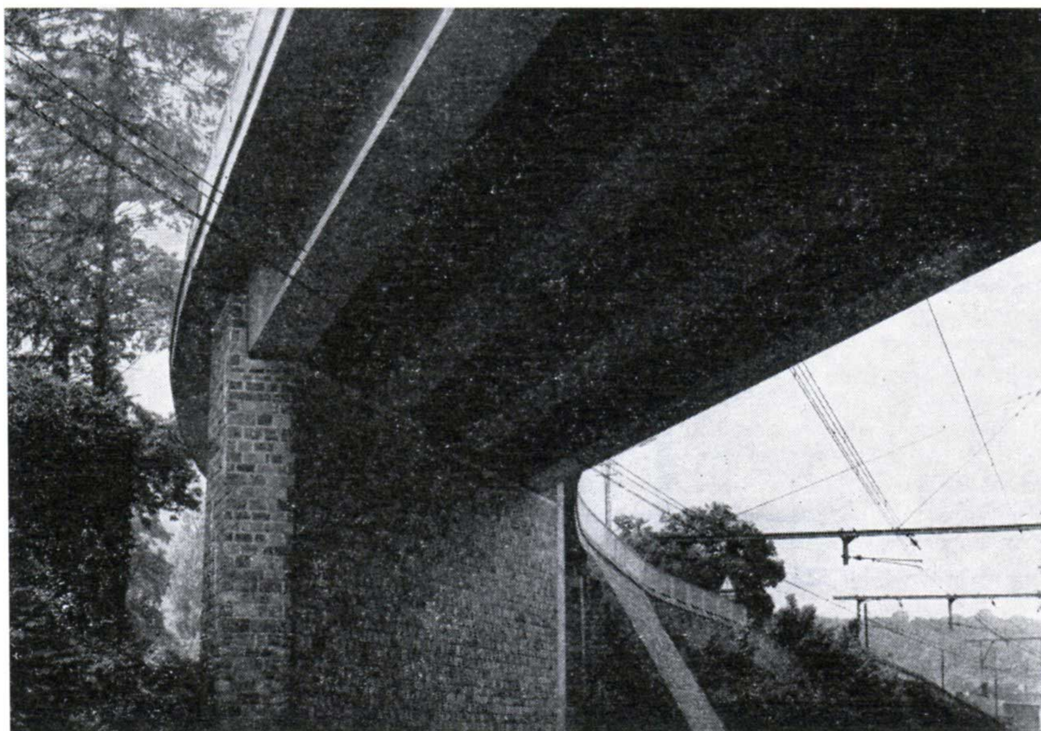
Pont routier sur la ligne à Namèche (photo S.N.C.B. - Cinéphoto)
