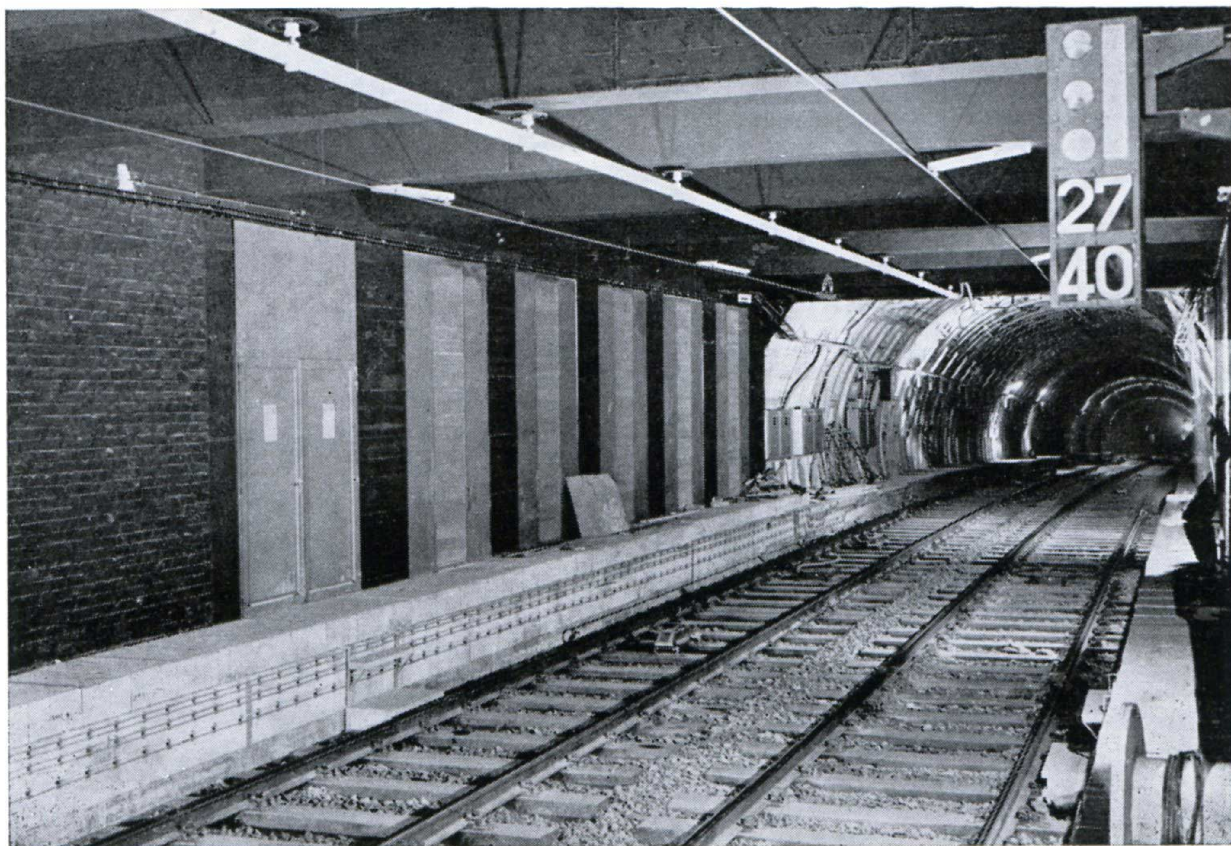
Signal lumineux du métro de Bruxelles au départ de la station «Arts» de la future ligne 1
