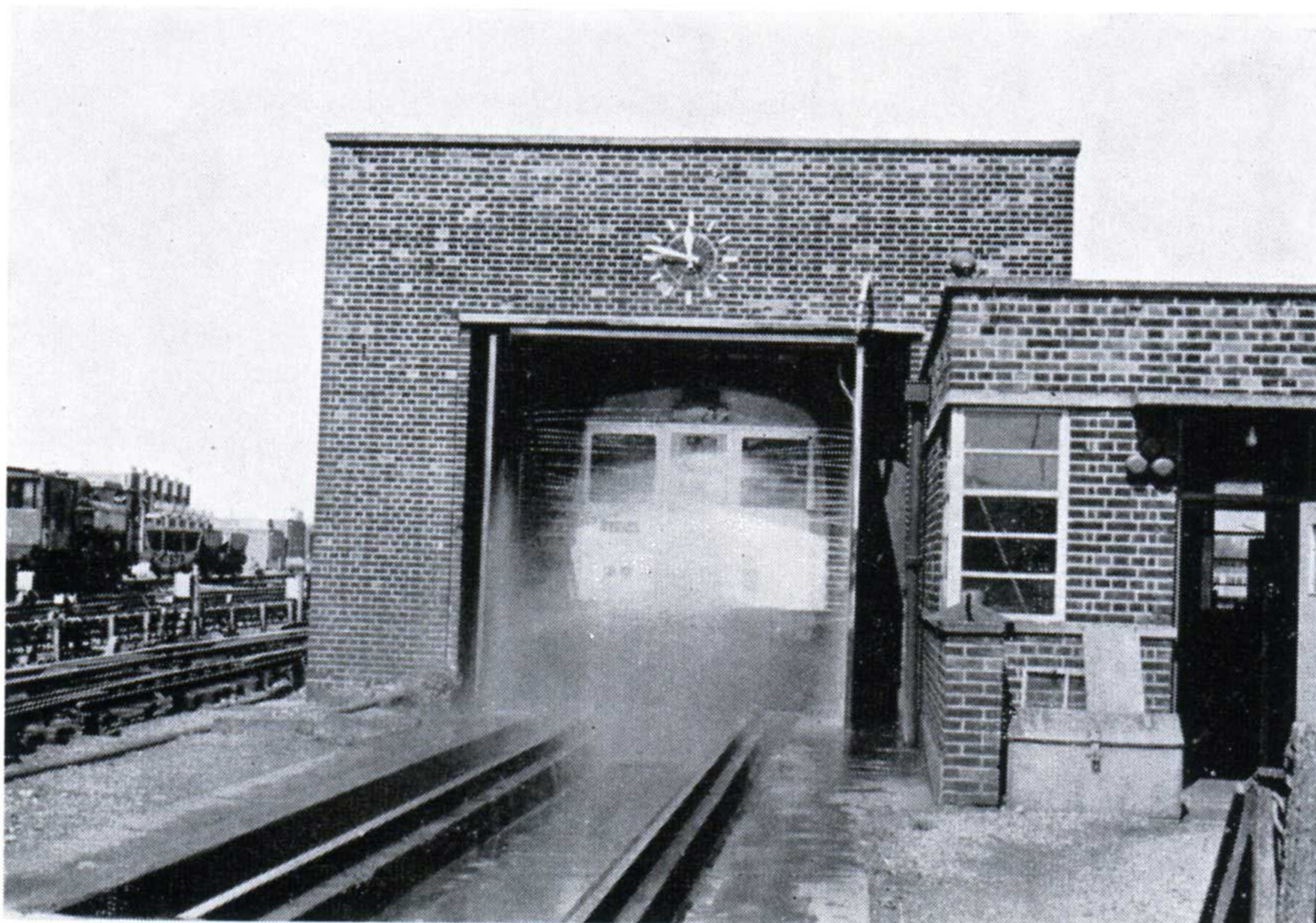
Poste de lavage automatique au dépôt de Naesden (photos de l'auteur)
