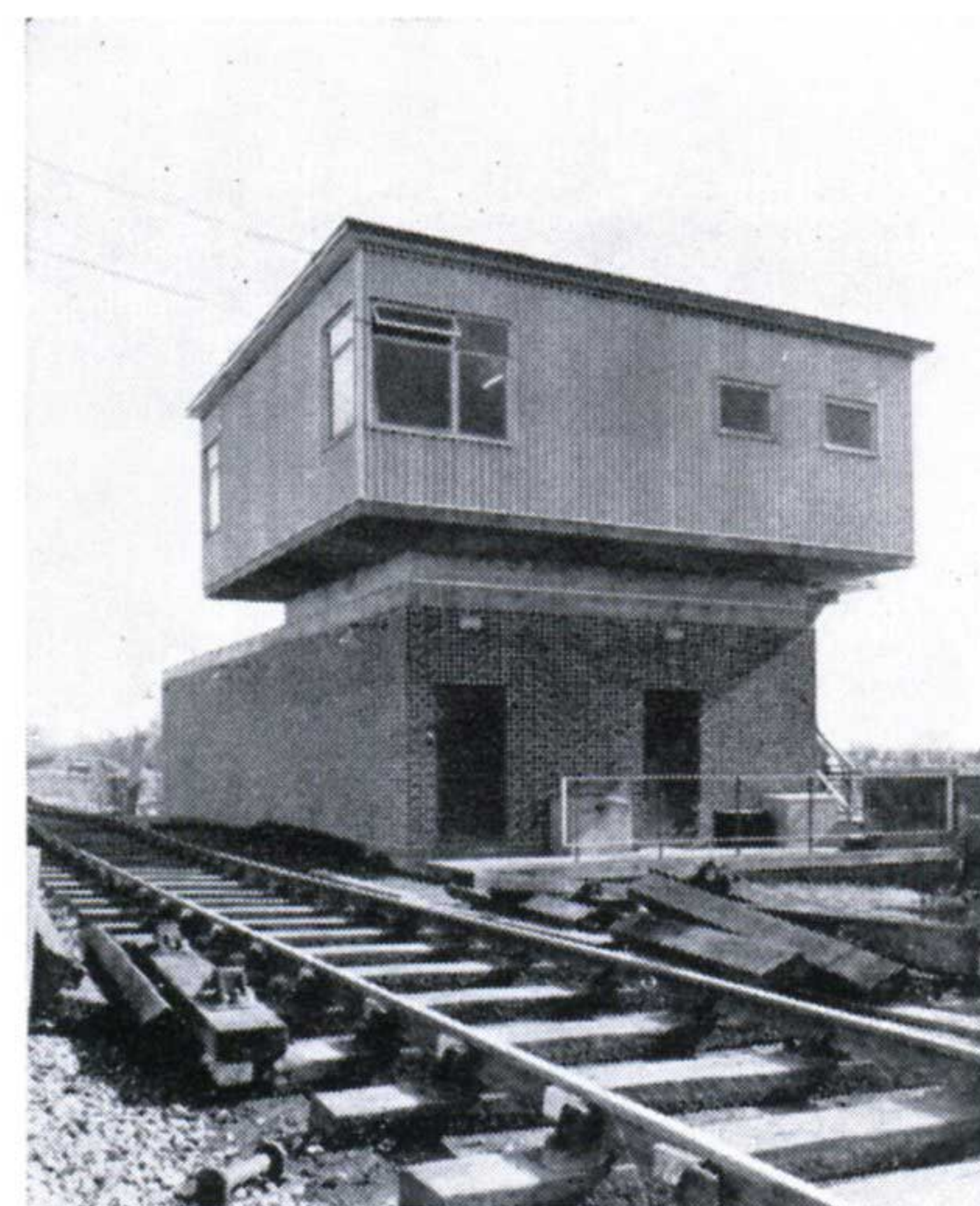
Vue extérieure de la cabine de signalisation d'Amersham sur la Metropolitan Line, avant et après les travaux de modernisation
