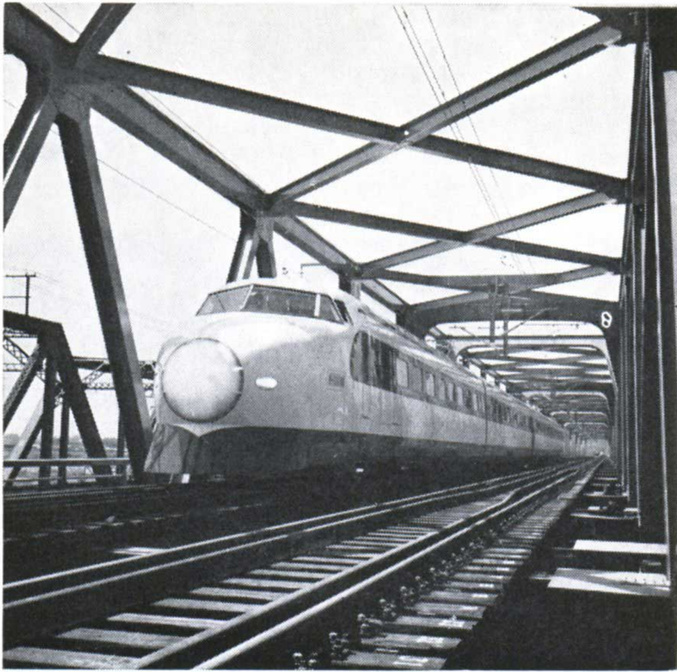
Passage en essai en 1962 d'une rame à 200 km/h sur le pont de Sokawayawa, long de 422 m — on notera l'apparente robustesse de la voie. (cliché R.T 83008)
