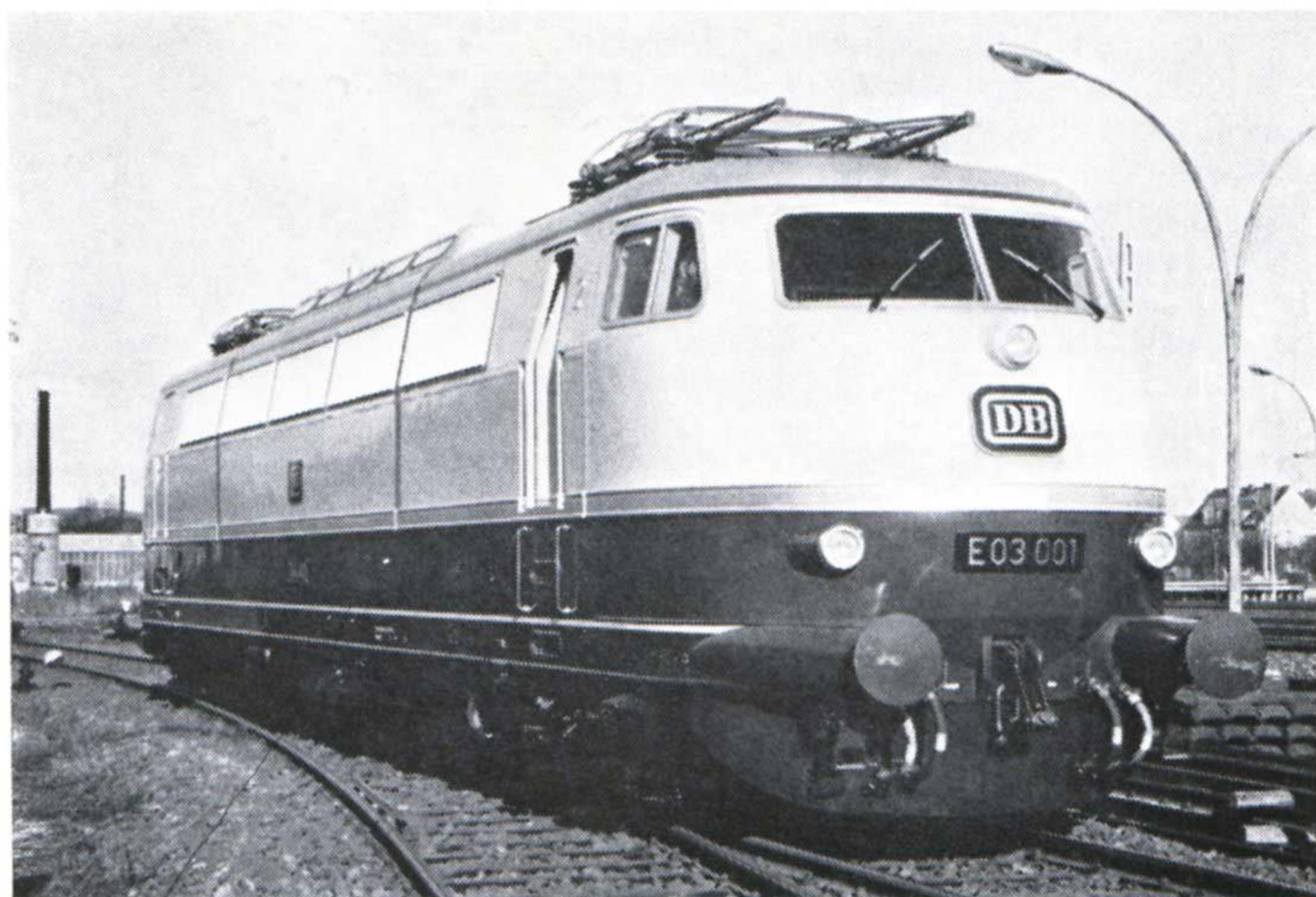
Locomotive CC, E03-001 de la DB devenue plus tard 103-001. C'est la première locomotive du monde construite pour courir à 200 km/h en service régulier.
