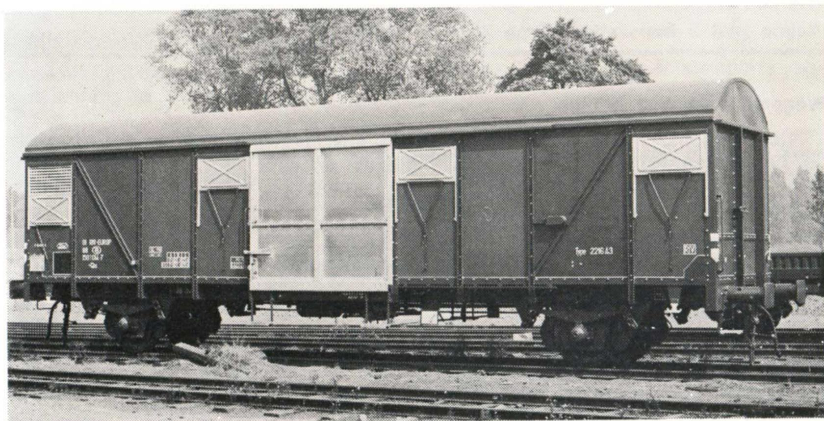
ballées. Leurs ouvertures latérales sont dimensionnées de manière à permettre le passage aisé d'un élévateur à fourche ou d'un « transpalette ».
