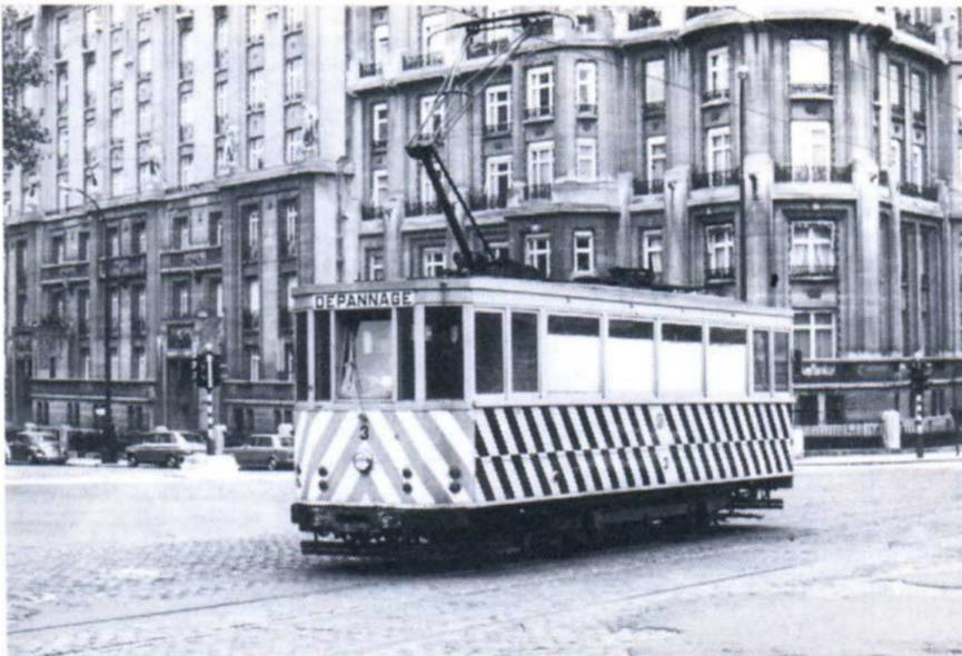
Motrice de dépannage n° 3 (ex-1753) dans son dernier état : pantographe, bouts repeints.
