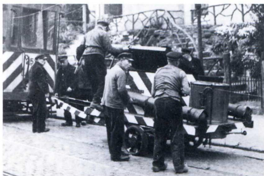
Résultat des efforts d'imagination imposés par les circonstances du moment (1940-1945) : le wagon dérailable à un seul essieu, utilisé pour le soudage des rails au chalumeau.
