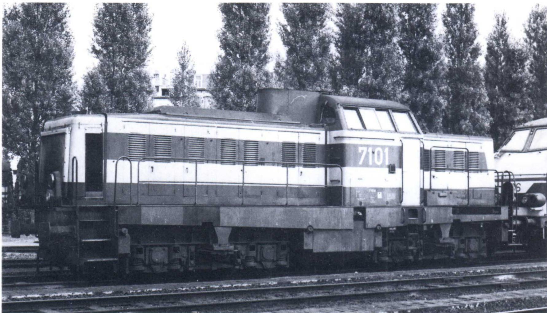
Une des trois locomotives de la série 71 (ex-série 66, ex-type 222), qui sont dorénavant affectées aux manoeuvres dans le port d'Anvers. La transformation a été réalisée en 1980 par l'atelier central de Salzinnes. (Photo G. Bricman)
