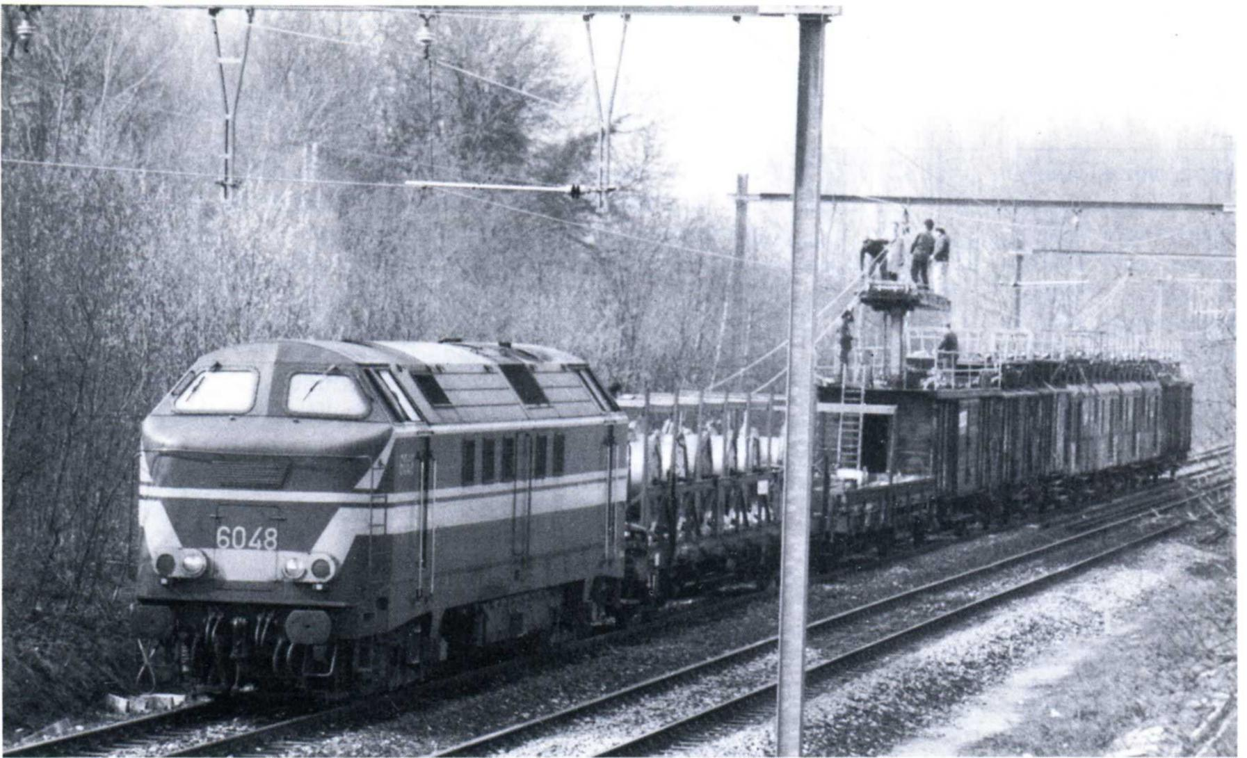
Pour réaliser l'électrification des lignes, les engins à traction diesel sont, évidemment, très sollicités. On voit ici un train dérouleur plaçant les nouveaux fils de cuivre lors de l'électrification de la ligne 94 (Hal - Tournai), dans les environs d'Ath. (Photo C. Dosogne)
