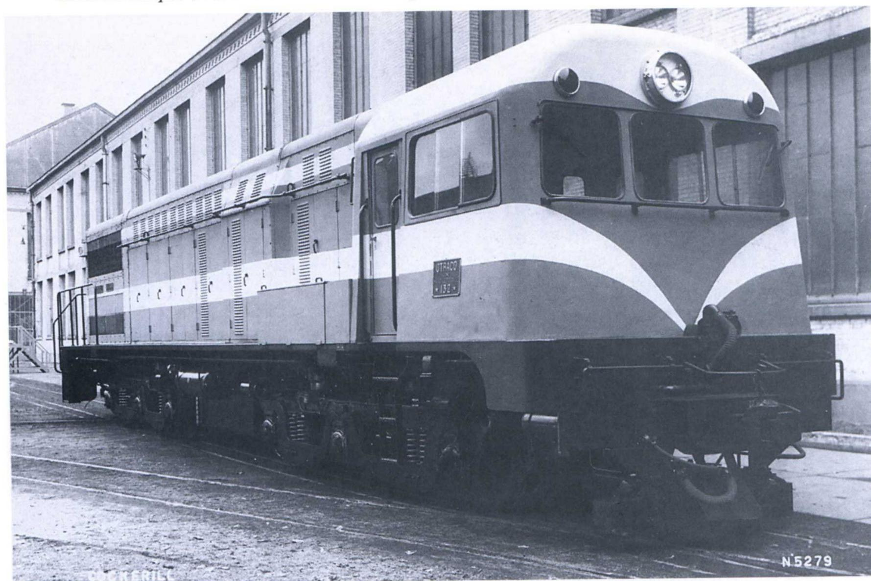
*Sur la cour du constructeur (Cockerill), la Cocolo diesel-électrique de 92 tonnes et 1750 chevaux, n° 132, en livrée bleu outremer et argent ; ces locomotives étaient prévues, tout comme les "ALCo-GE" et les "Baume et Merpent", pour circuler accouplées dos à dos.*
