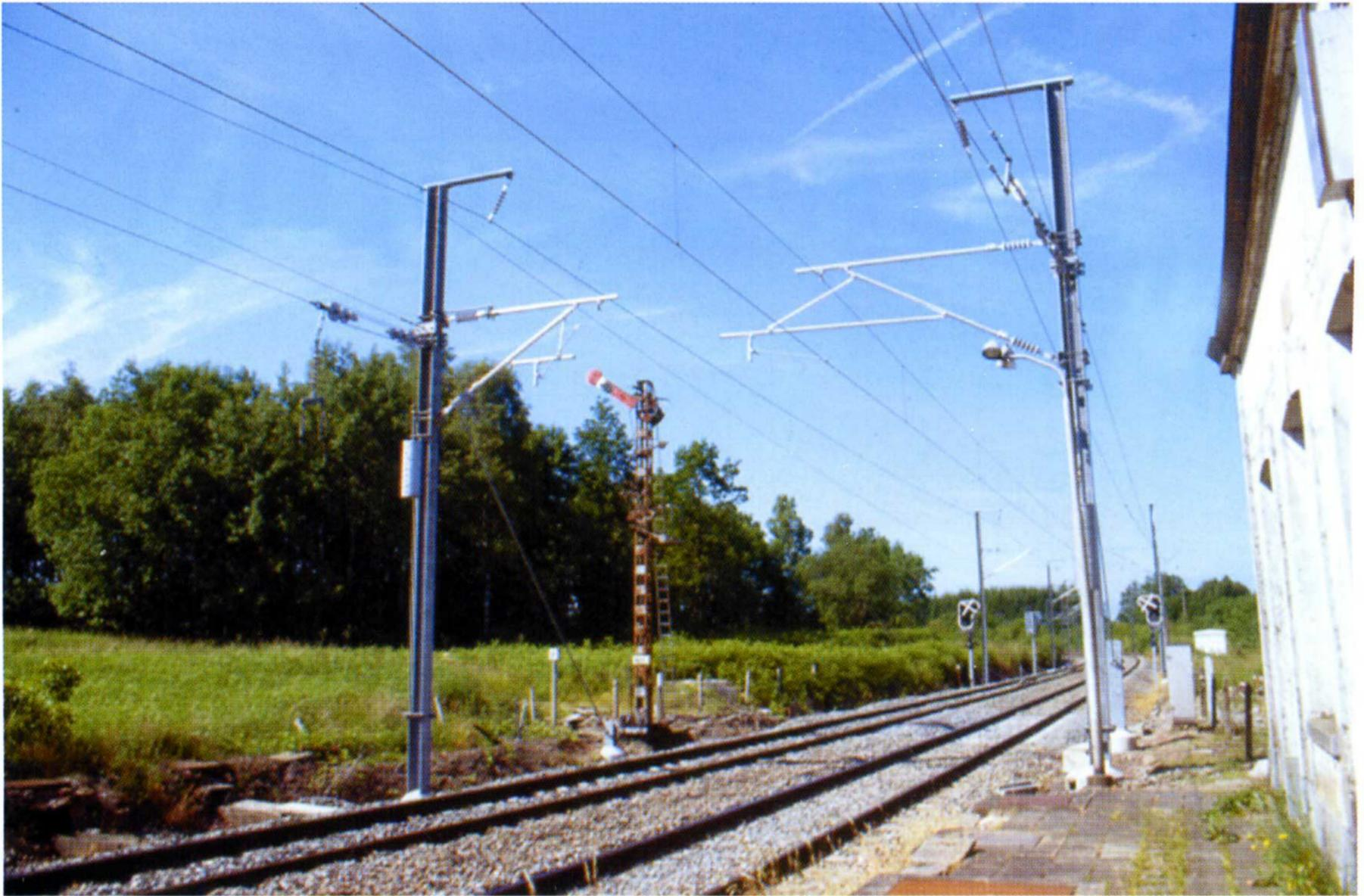
*A l'ancien point d'arrêt de Straimont en juillet 2002: signal à palette, nouvelle caténaire et nouveaux signaux pas encore en service.*
