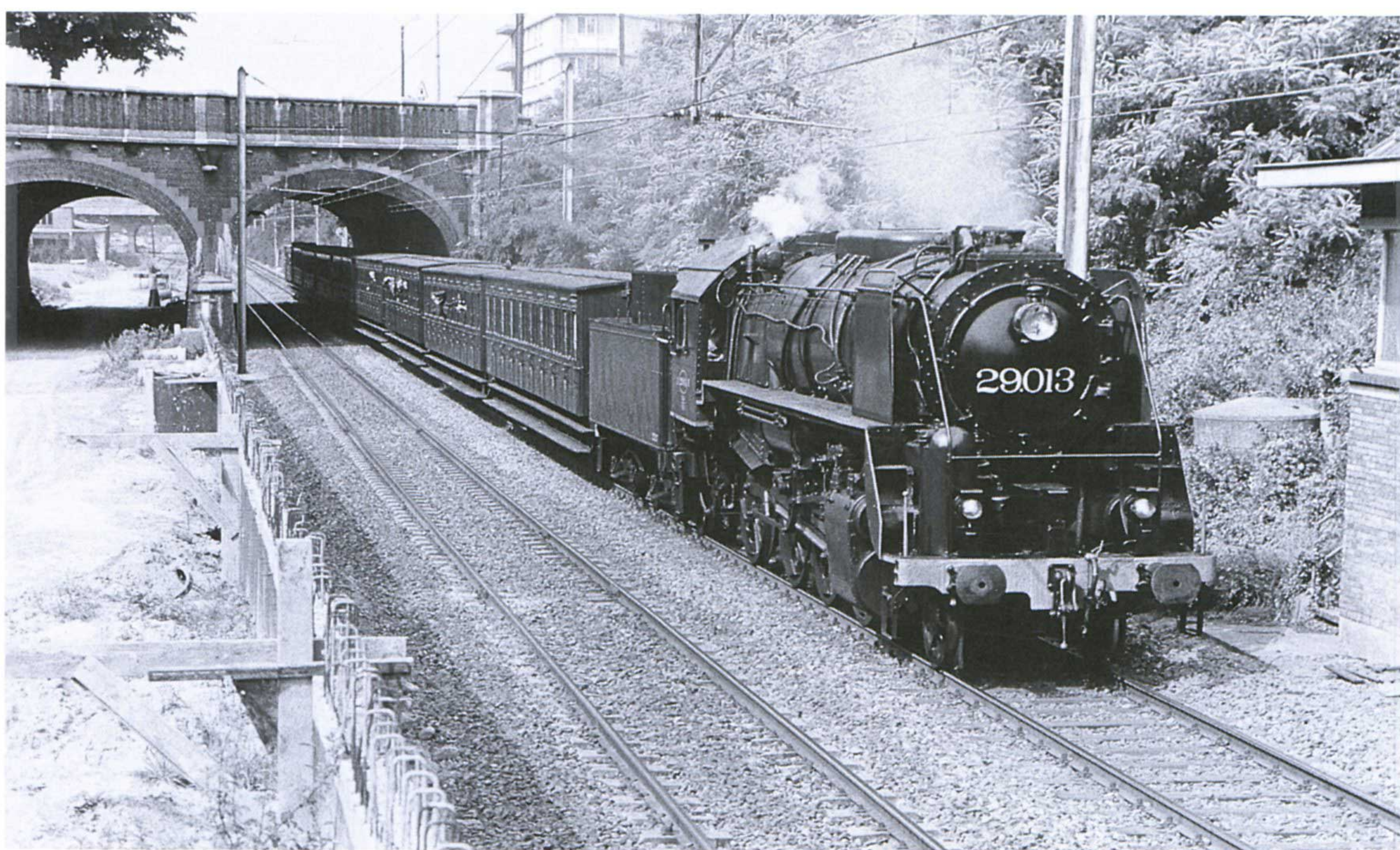
Le 2 septembre 1972, le premier train spécial « vapeur » remorqué par la locomotive 29.013, composé de voitures à caisses en bois du type « GCI », passe sous le boulevard Louis Schmidt (Etterbeek), le long du site de la future ligne 1A du métro bruxellois.
