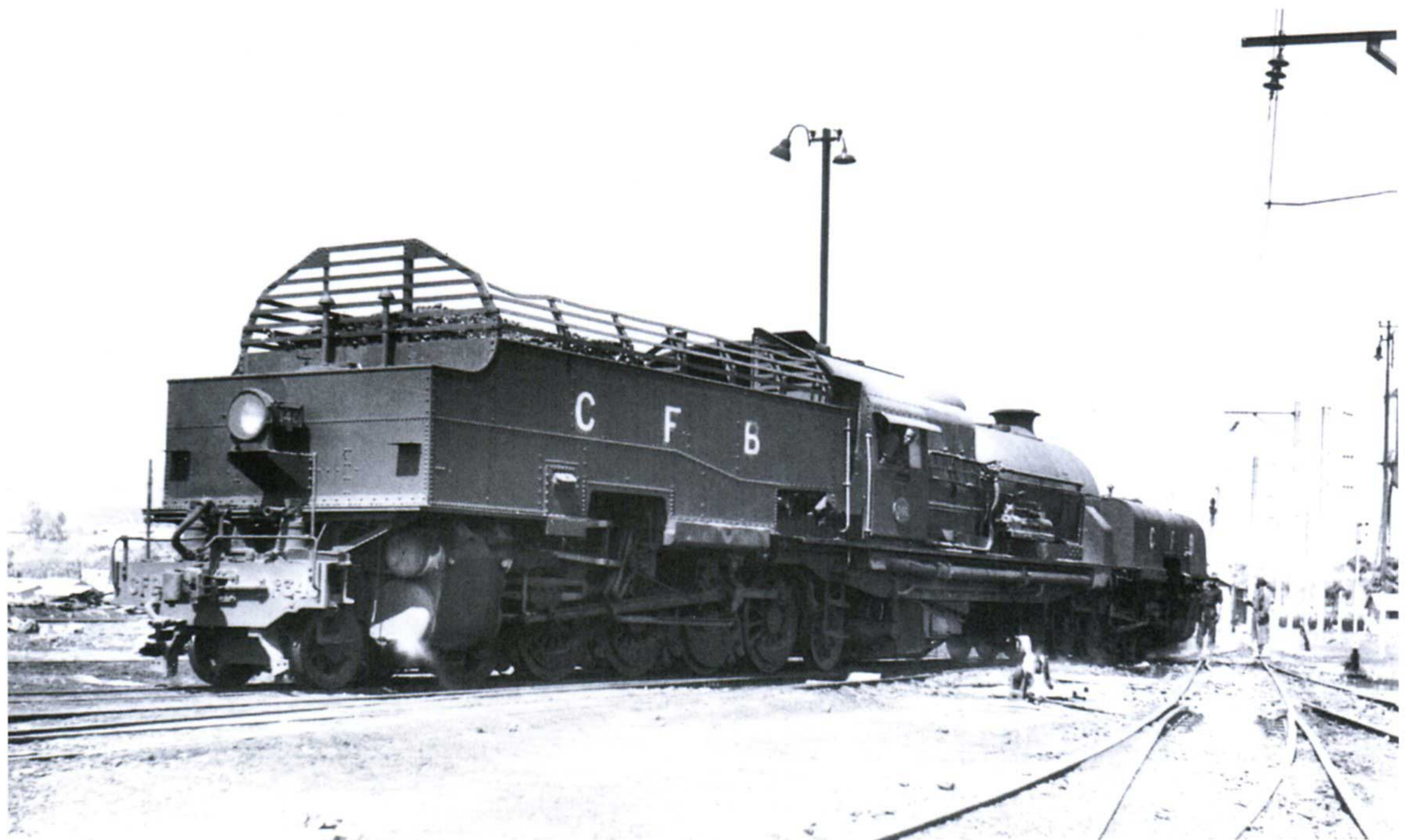
Au début de 1953, sur les voies de l'atelier « vapeur » de Jadotville, présentation aux membres de l'ABAC de la locomotive « Garratt » 4-8-2 + 2-8-4 n° 340 du « Caminho de Ferro de Benguela » (Angola).
