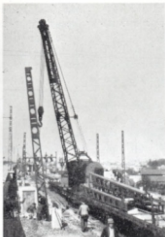
Implantation des pylônes.
