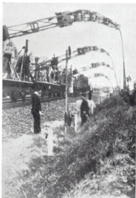
Mise en place des câbles téléphoniques. (Photo S.N.C.F. - région Sud-Est-VB)
