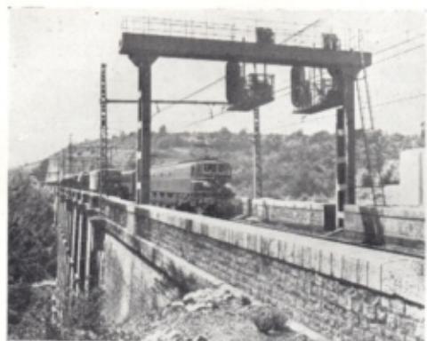
Banalisation des voies au viaduc de Velars. (Photo S.N.C.F.)
