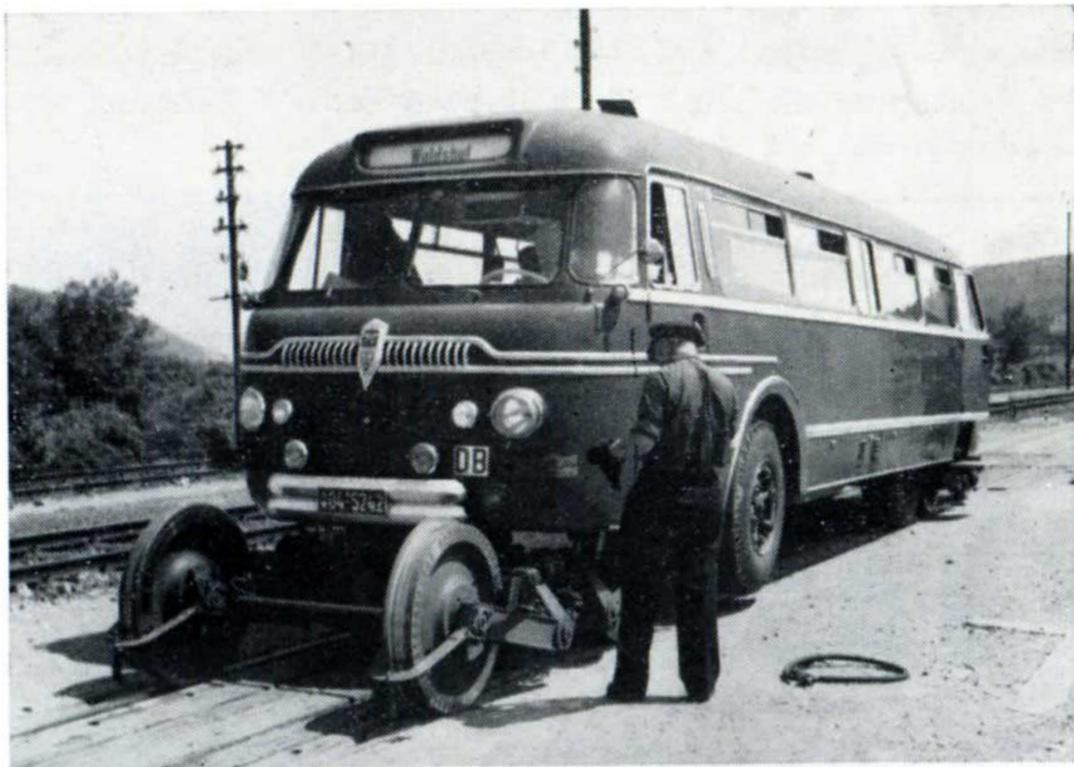
Vue d'ensemble d'un des deux bogies spéciaux du Bahnbus.
