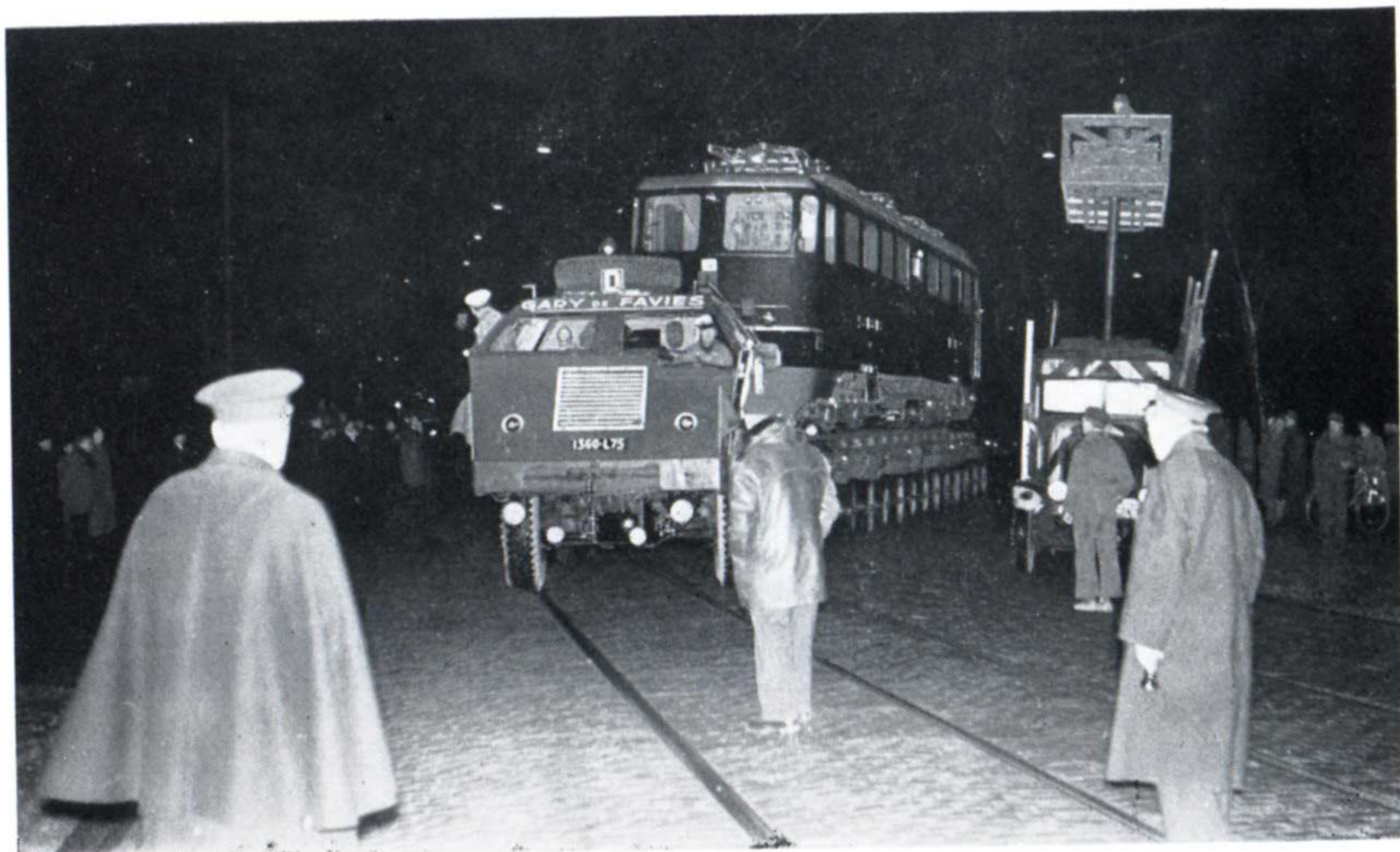
Transport de nuit de la locomotive Ae 6/6 des C.F.F. par la S.C.E.T.A. — traversée d'une ligne de tramways — on remarque, à droite, une voiture-échelle de la S.T.I.B. chargée de soulever la nappe des lignes aériennes afin de dégager le passage — à l'avant-plan, à gauche et à droite, deux contrôleurs de la S.T.I.B. surveillent la délicate opération.
