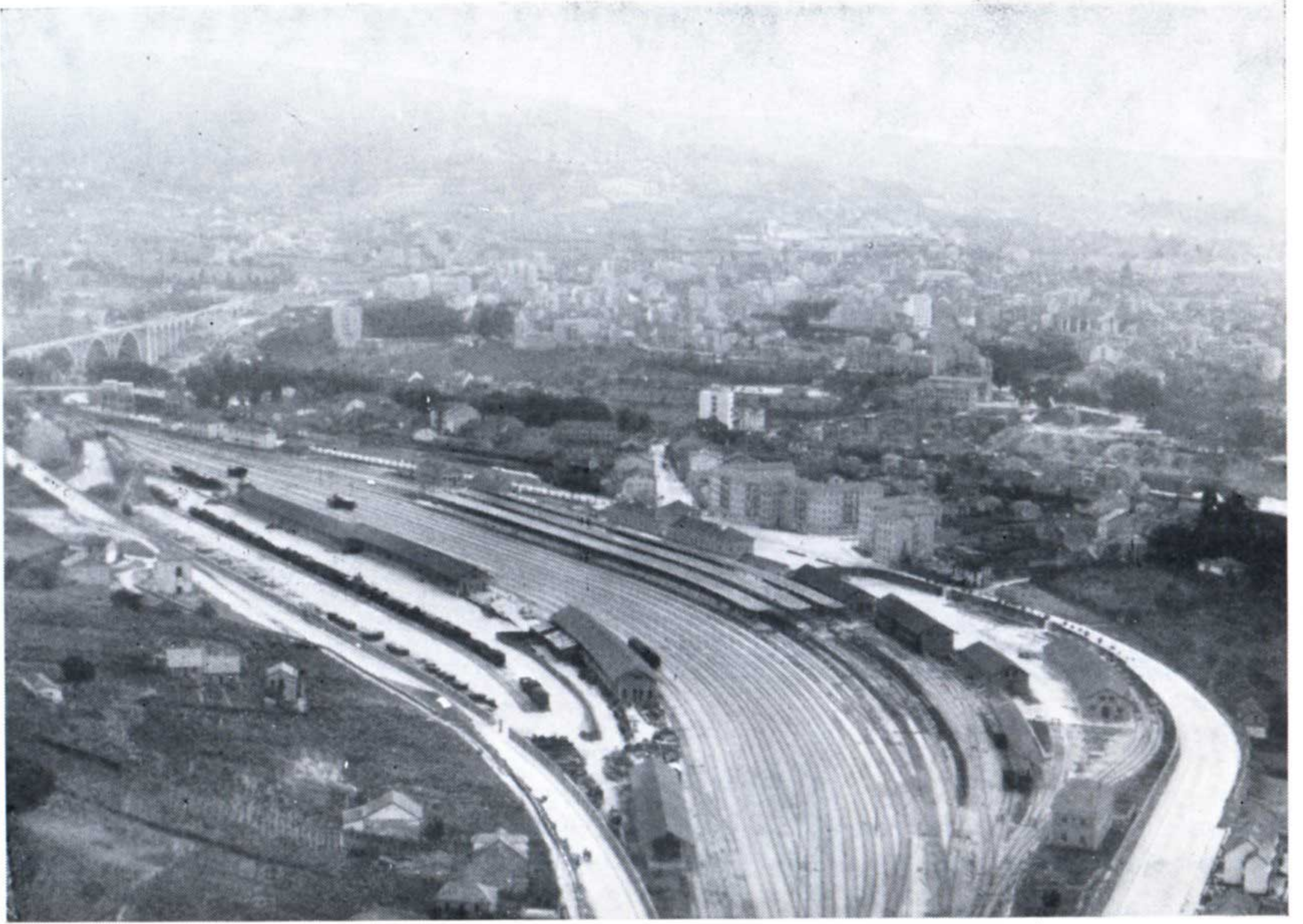
Vue panoramique de la gare de Orense-Empalme.
