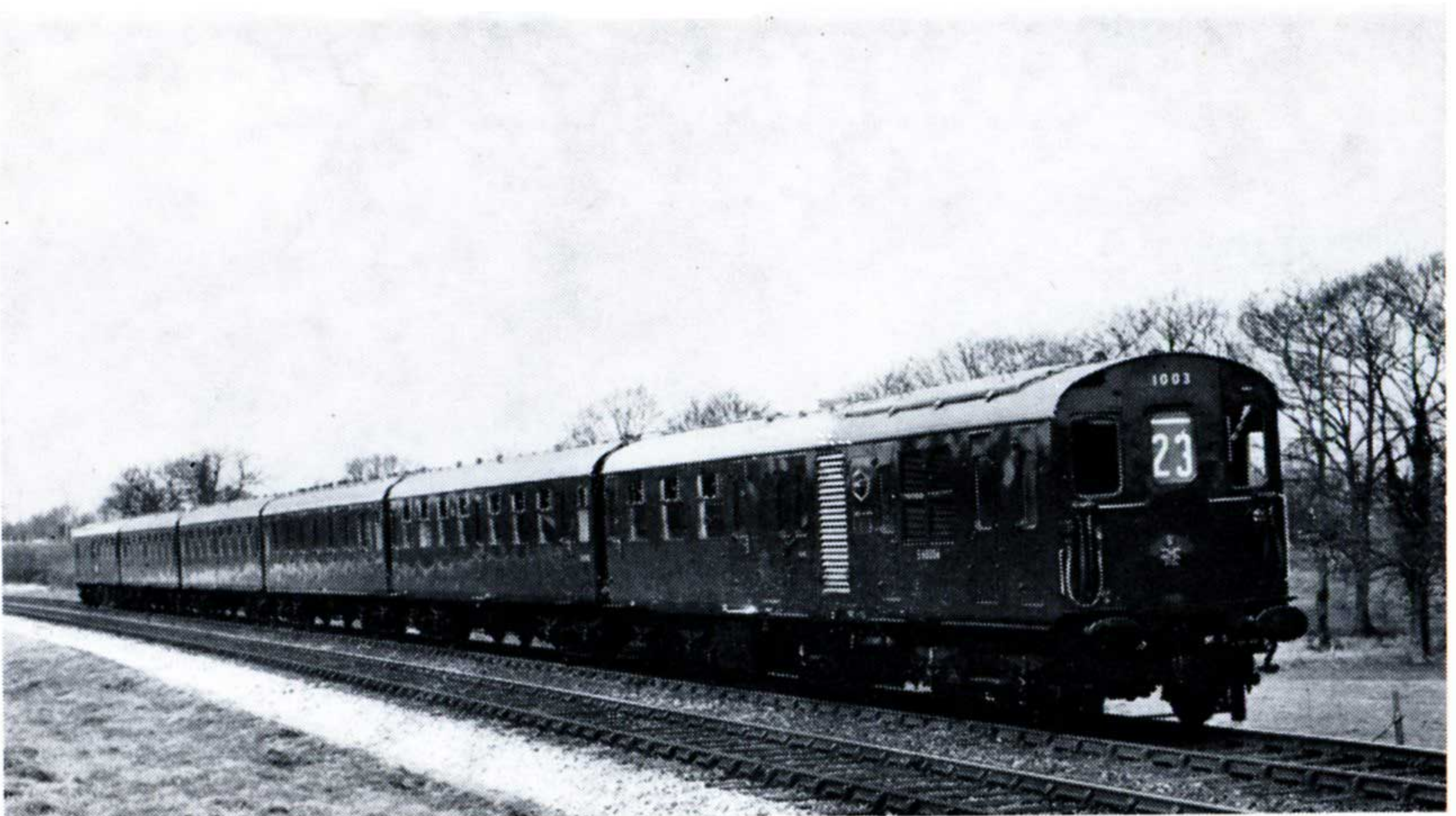
Une des rames Diesel-électriques sextuples construites à Eastleigh pour la ligne de Hastings. Il s'agit ici d'une des sept premières, avec caisses de 17690 mm. — 42 + 200 places — 198 tonnes — 1.000 ch — 120 km/h. (Photo British Railways S. Region)
