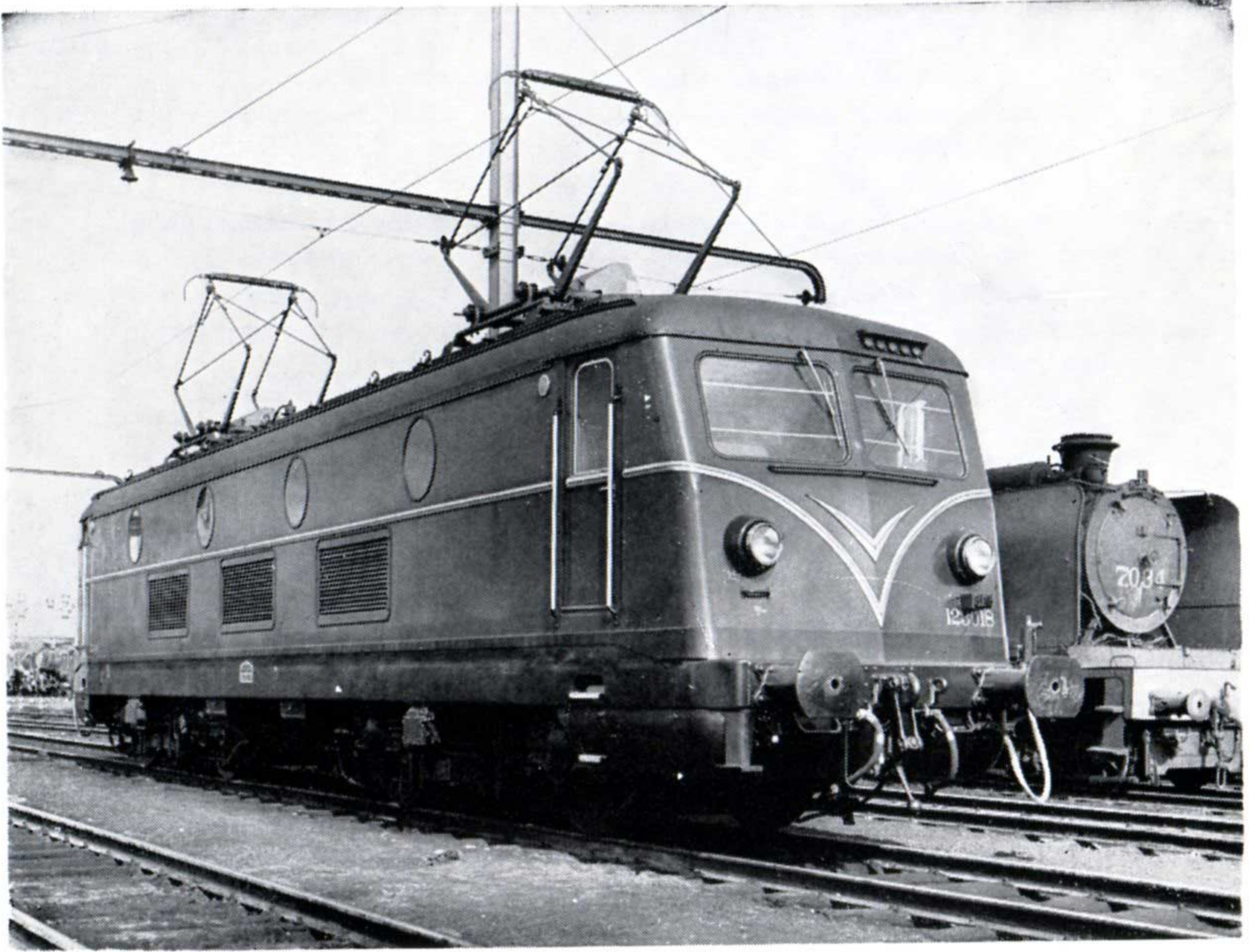
Fig. 4. — Locomotive BB type 123 de la S.N.C.B. Poids : 92 T Puissance unihoraire : 2.560 CV. (Cliché A.R.B.A.C.)
