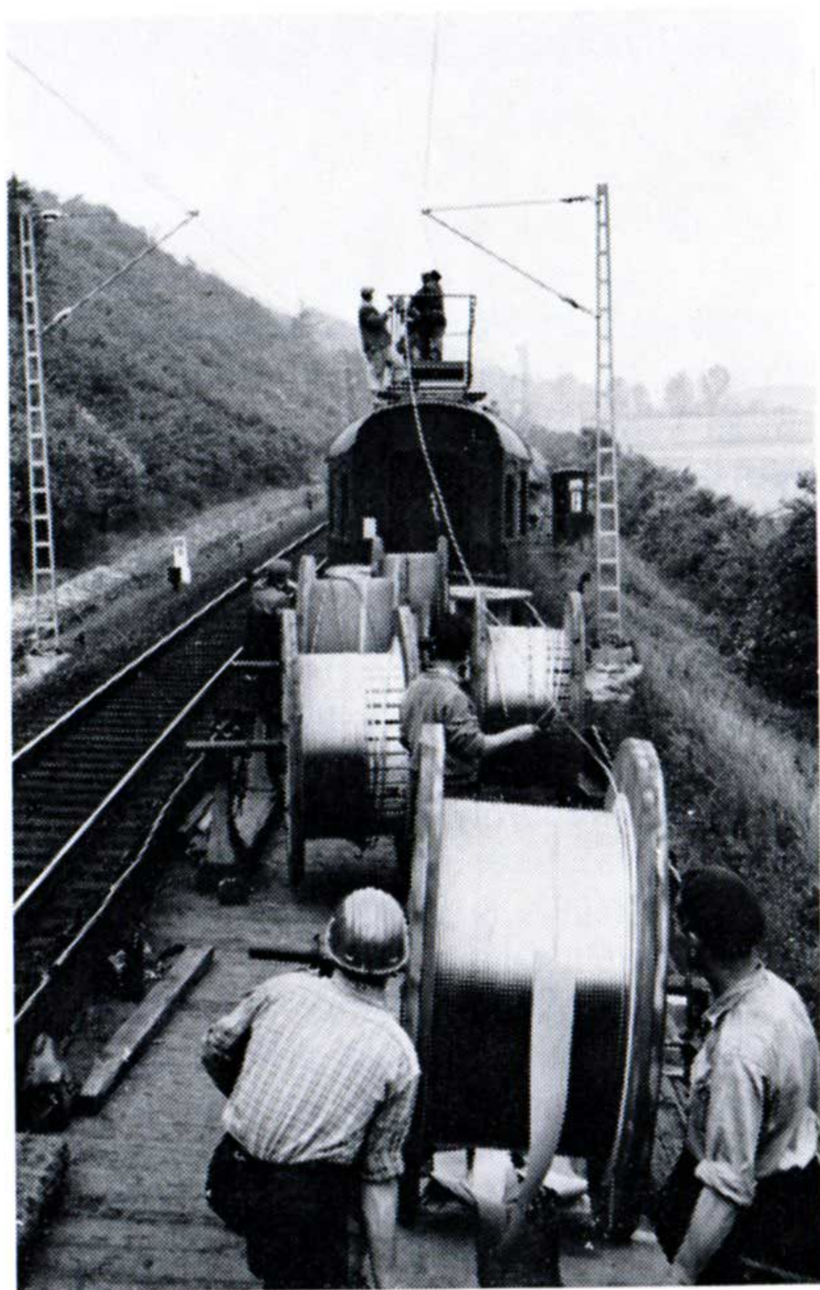
Train dérouleur de caténaire au travail entre Gottingen et Hanover.
