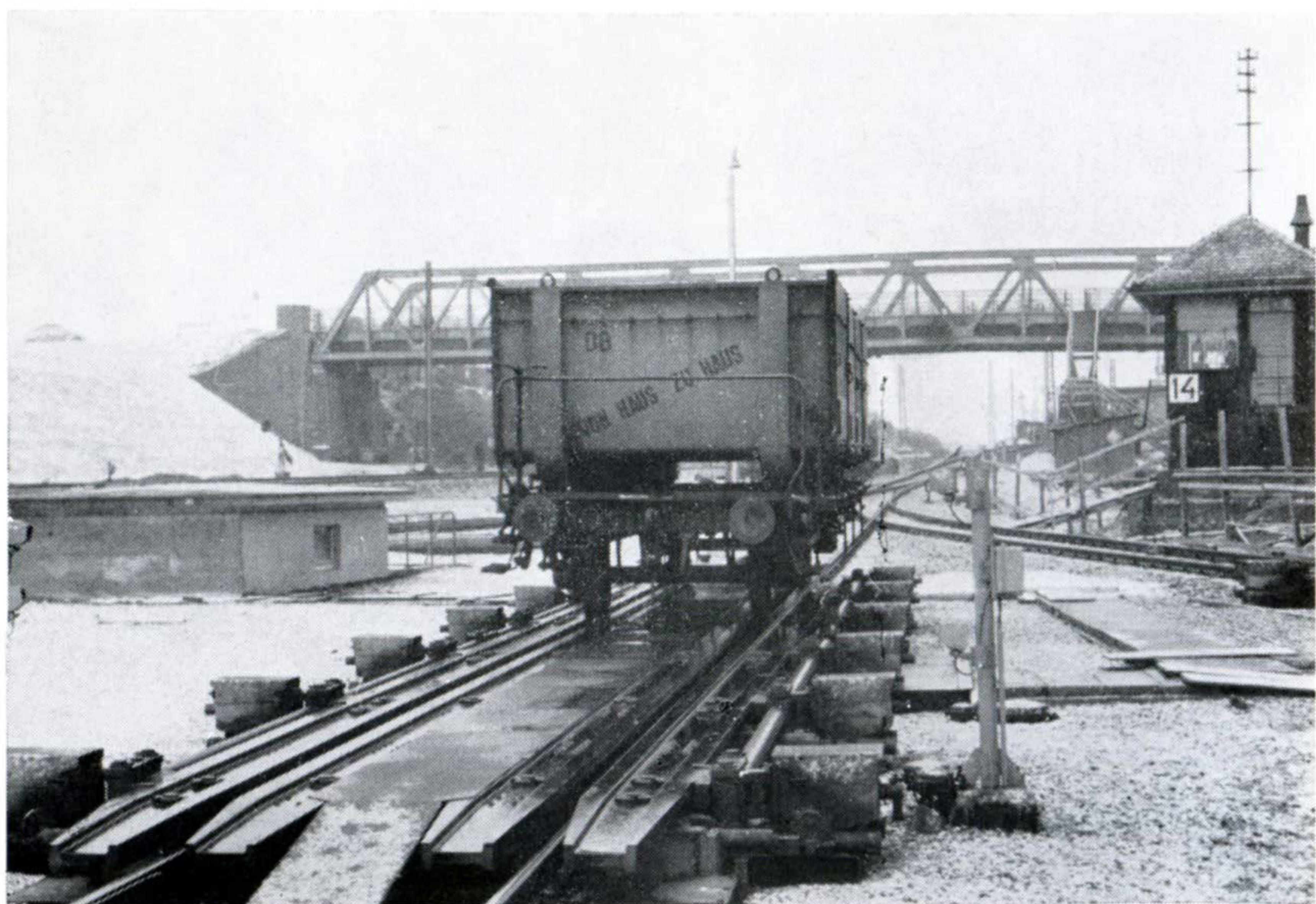
Ci-dessus : gare de triage de Köln-Kalk-Nord et, ci-dessous, frein de voie à commande électronique par cellule. (Photos D.B. Bildarchiv)
