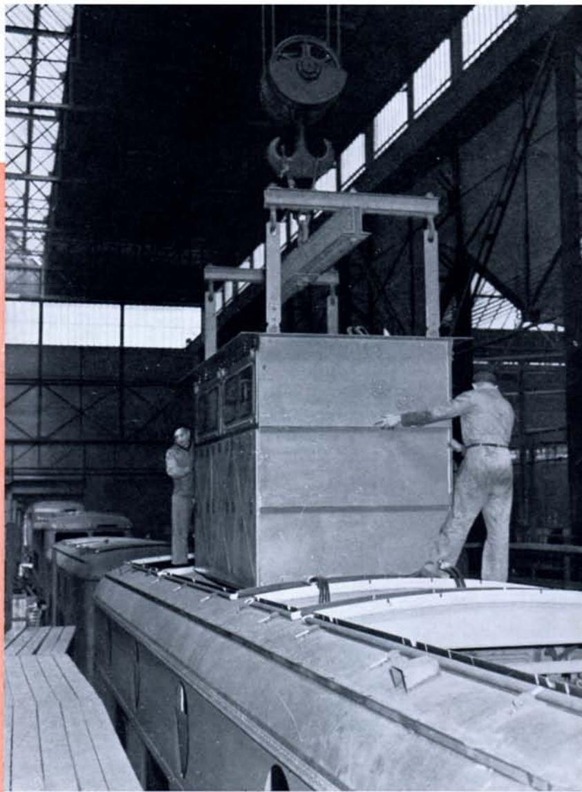
Fig. 11. - Descente du bloc des JH préfabriqué, dans la caisse de la locomotive.
