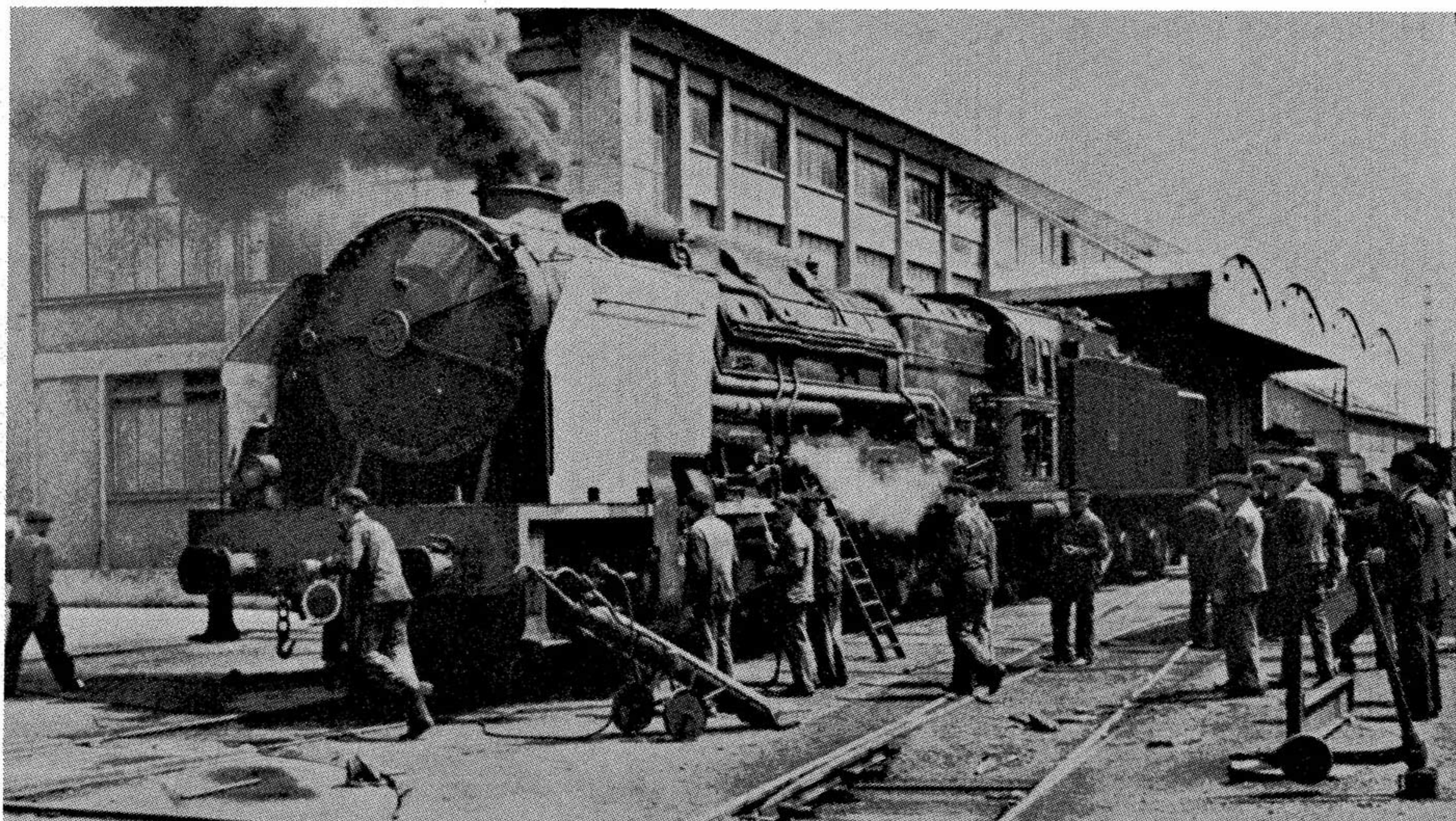
De 1F-zescilinder-compound 160A1 bij het verlaten van de werkplaats van Tours in juni 1940. Deze lokomotief met 2 hoge en 4 lage druk-cilinders was juist tijdig klaar om ze uit de handen van de Duitsers te houden. Ze werd in Brive verborgen tot na de oorlog.
