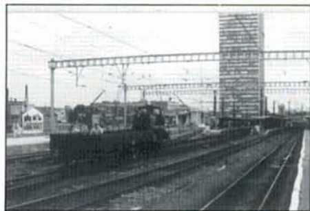
Les nouveaux poteaux supports de caténaire installés l'année passée à Bruxelles-Midi utilisent des aubans inusités sur le réseau, de forme légèrement bombée.
