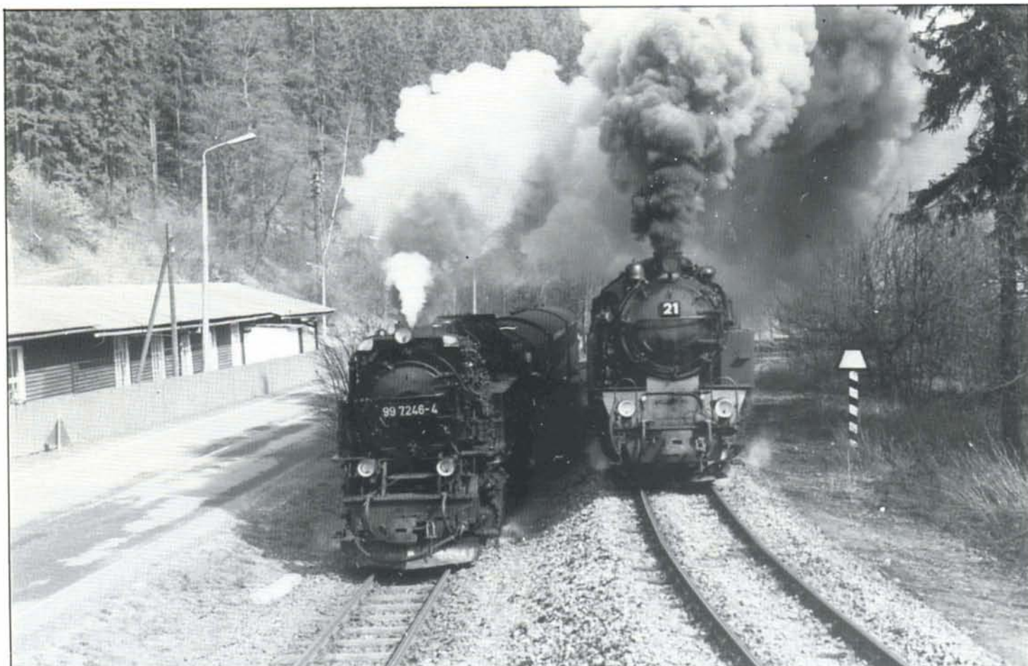
PHOTO 17-10 Le fameux départ simultané d'Alexisbad. A gauche : la 99.7246-4 en tête du train 8963 pour Hasselfelde. A droite : la 1-3-1 T n° 21 se dirigeant vers Harzgerode. Cette petite locomotive unique fut construite en 1939 par Krupp pour le Nordhausen Wernigeroder Eisenbahn. Elle porta ensuite le numéro 99.6001 à la DR. Au début de 1993 elle fut remise en livrée et numérotation d'origine (NWE 21).
