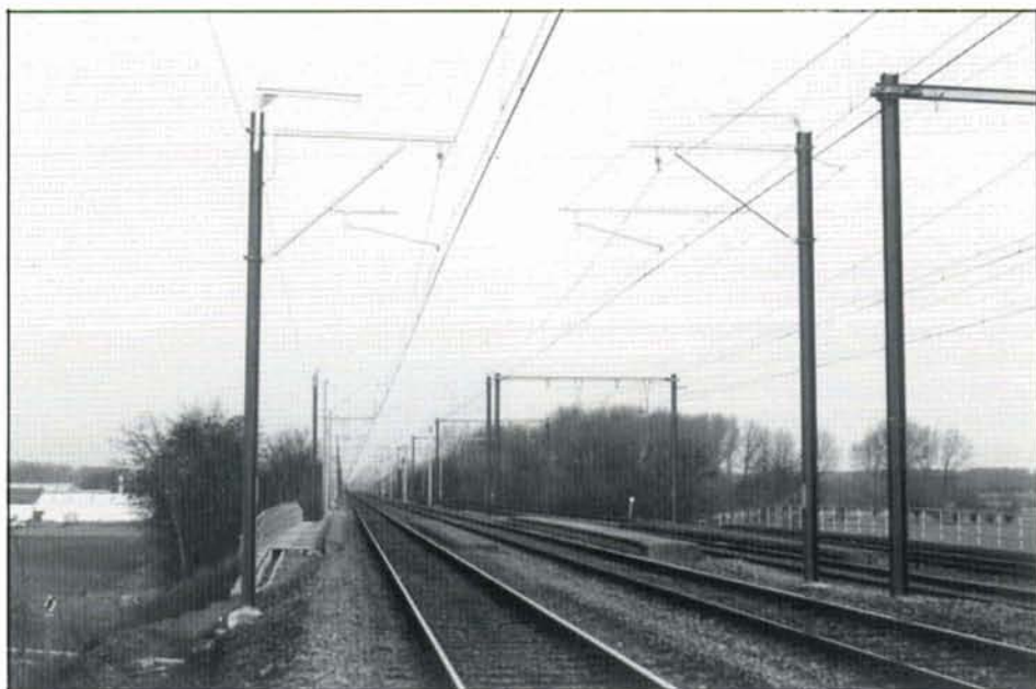
Au début du mois de décembre, 5 poteaux consécutifs situés entre Vilvoorde et Epegem étaient déjà équipés de leurs consoles en aluminium. Epegem, 28 décembre 1993.
