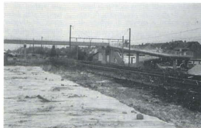
La situation en gare de Buizingen. Les travaux de renouvellement de la voie B de la ligne 96 sont en cours; les nouveaux poteaux supports de caténaires sont plantés. A droite, l'emplacement de l'ancienne gare. Photo B. Dieu, 15.06.94
