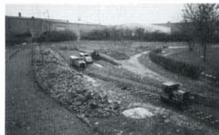
La nouvelle gare de triage a été inaugurée lors de nos journées d'ouverture en avril dernier.
