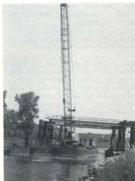
Une autre vue de l'avancement du chantier du viaduc d'Antoing vu vers la France. Les travaux préparatoires au lancement du tablier central sont en cours. Ph. Dieu, 14.07.94.
