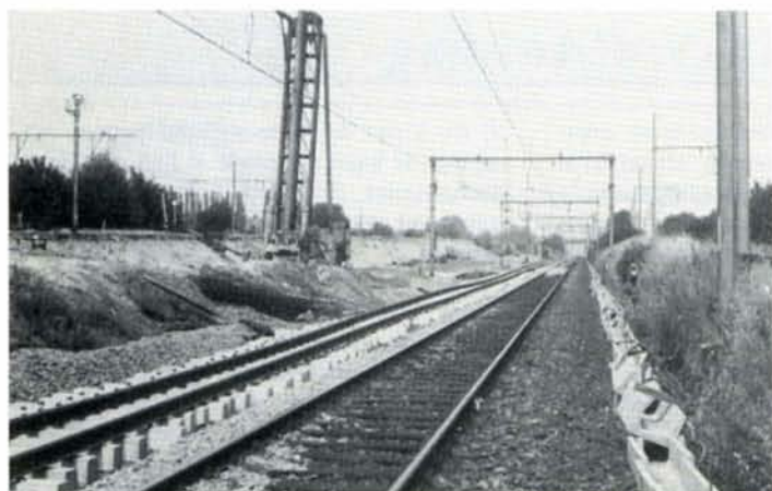
A Hal, côté Bruxelles, la voie B de la ligne 96 est en cours de remplacement. La photo est prise à l'endroit où se construit le nouveau pont qui permettra aux deux voies de la ligne 26 (Ceinture Est de Bruxelles) de franchir les deux voies TGV et les deux voies de la ligne 96. Photo Baudouin Dieu, 15.06.94.
