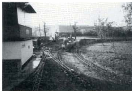
Les travaux de terrassement du triage.
