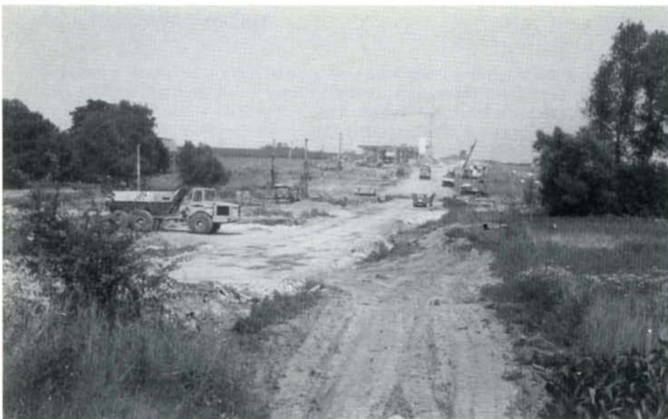
Vue générale du chantier du viaduc d'Arbre qui franchira la vallée de la Dendre. La photo est prise de la ligne 90 Mons-Ath vers Bruxelles. C'est le seul chantier actuellement autorisé entre Antoing et Ath. Photo Baudouin Dieu, 14.06.94
