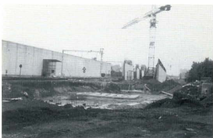
Dans l'ancienne cour à marchandises de Lembeek se construisent les murs de soutènement de la future plate-forme qui aboutira au viaduc.
