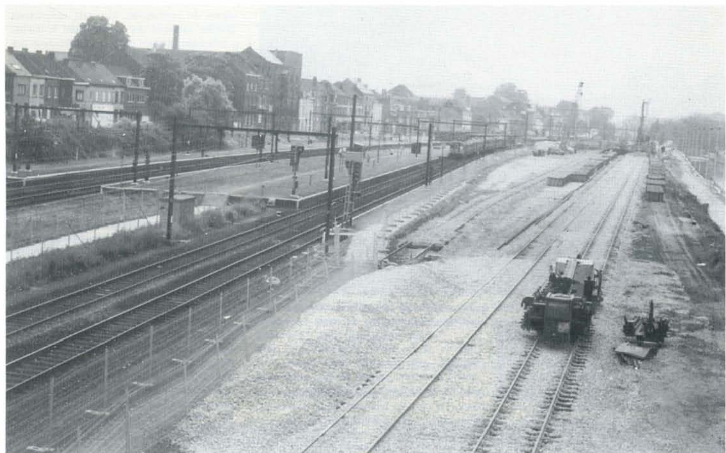
Vue générale de la gare d'Hal prise de la passerelle provisoire côté Nederhem. On voit nettement sur la droite les trois nouvelles voies en construction qui seront utilisées lors de la démolition du reste de la gare. Rappelons que les lignes TGV, 94 et 96 seront enterrées à cet endroit.
