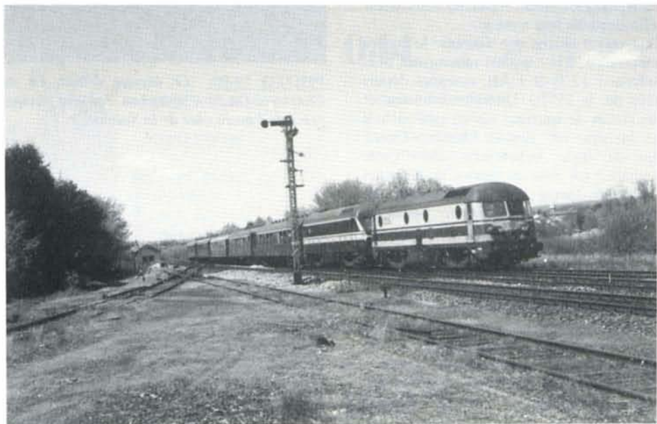
PHOTO 19-03 Le train fut garé à Florenville pour laisser passer un autorail vers Virton. Il est photographié à l'entrée de la gare à côté du signal de sortie pour les trains se dirigeant vers Bertrix.
