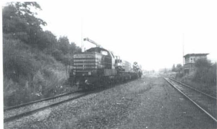
La plantation des poteaux à l'entrée de la gare de Quiévrain. Le train est remorqué par la 7306. 4 juillet 1994.
