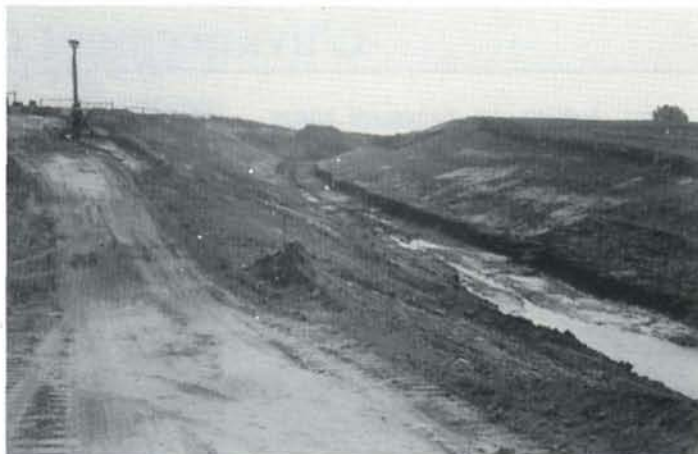
La courbe de raccord se détachant de la ligne nouvelle vers la ligne 78 est déjà creusée en partie. Elle sera franchissable à 160 km/h et rejoint la ligne Mons-Tournai entre Antoing et Maubray.
