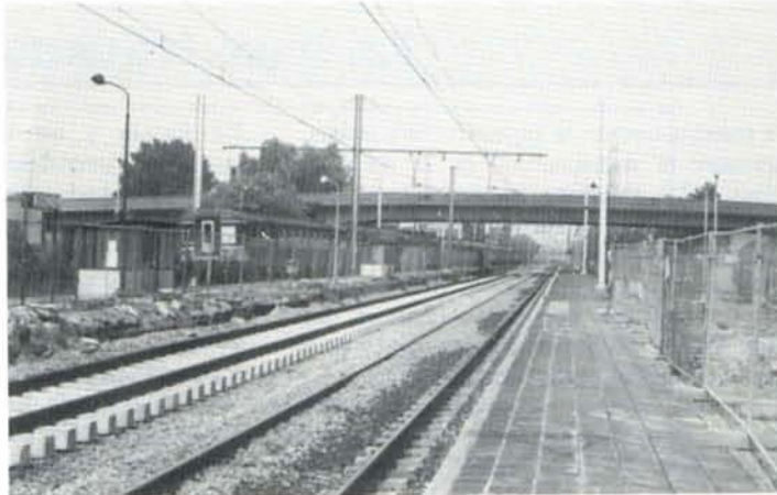
La situation en gare de Buizingen. Les travaux de renouvellement de la voie B de la ligne 96 sont en cours; les nouveaux poteaux supports de caténaires sont plantés. A droite, l'emplacement de l'ancienne gare. Photo B. Dieu, 15.06.94
