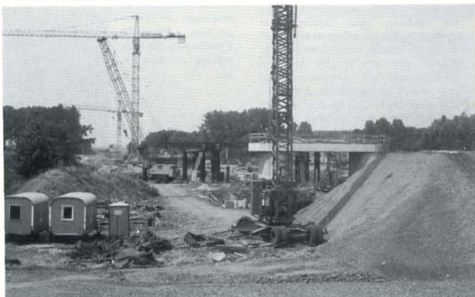
Une autre vue de l'avancement du chantier du viaduc d'Antoing vu vers la France. Les travaux préparatoires au lancement du tablier central sont en cours. Ph. Dieu, 14.07.94.
