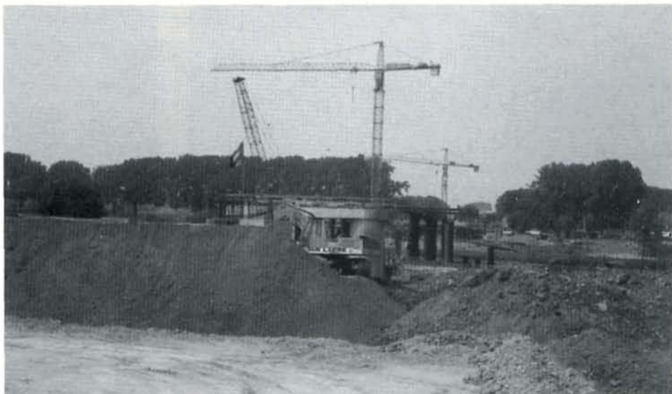
Le viaduc d'Antoing franchira l'Escaut. Deux piles et une culée sont déjà réalisées. Photo B. Dieu, 14.07.94
