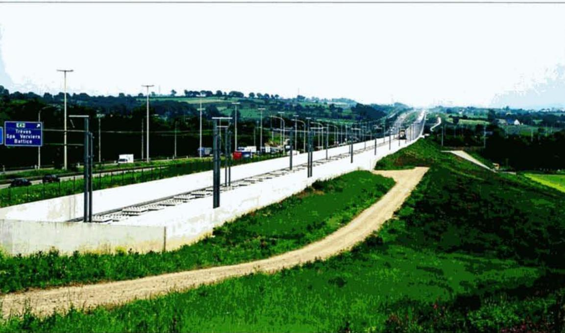
Le viaduc de Battice, long de 1300 mètres, est achevé. Les poteaux caténaux sont posés, le fil de terre et le feeder sont tirés.
