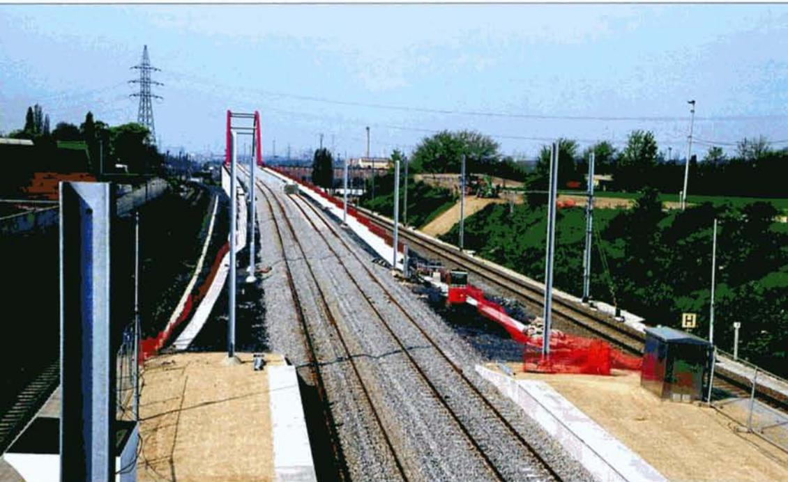
Le 3 mai, vue prise de Haren-Sud vers Schaerbeek. Les deux nouvelles voies de la ligne 36N sont posées au milieu de la ligne 36 et empruntent le nouvel ouvrage d'art qui permet le franchissement des lignes 25 et 27, et les voies de garage de Schaerbeek. Baudouin DIEU.
