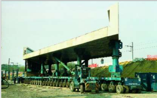
Un des deux tabliers du pont qui permettra à la ligne 26 de franchir la ligne 161 à Watermael. On remarquera l'extraordinaire train routier qui servira à déplacer le tablier vers son emplacement définitif. Ci-dessous, une autre vue du tablier. A droite, on aperçoit la grue qui s'est renversée sur la voie vers Namur de la ligne 161. Christian DOSOGNE, 6 avril 2007.
