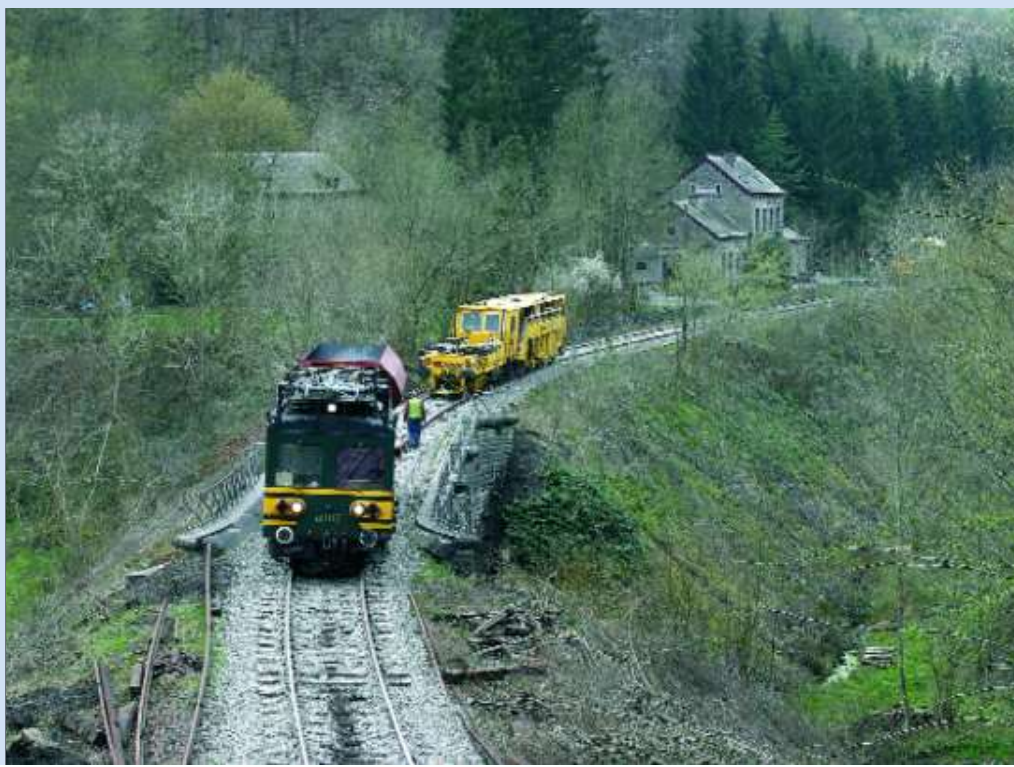
Le 10 avril 2007, la ligne était ballastée à l'aide de l'ES 102 tandis que deux engins spécialisés loués à Infrabel opéraient pour cribler, bourrer et rectifier la voie. Le second engin se trouve à droite de la gare, derrière les arbres. Christian AUQUIERE.
