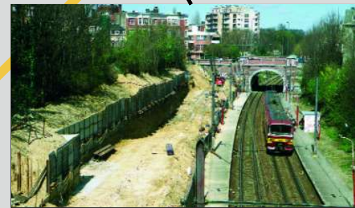
Le nouveau tunnel Schuman - Josaphat débouchera à hauteur de l'actuel point d'arrêt de Meiser sur la ligne 26. Christian DOSOGNE, 16 avril 2007.
