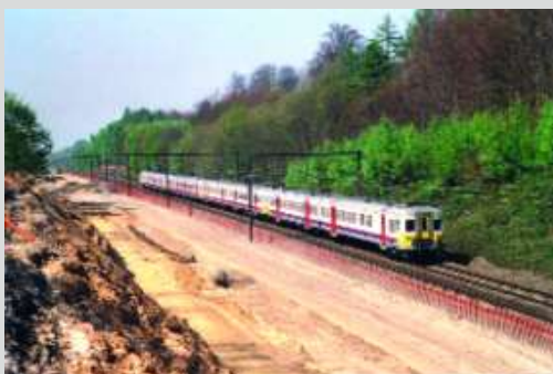
Dans la forêt de Soignes, les travaux de terrassement avancent de Groenendaal vers Boitsfort. Un train se dirige vers Ottignies. Christian DOSOGNE, 17 avril 2007.
