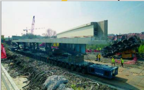
Un des deux tabliers du pont qui permettra à la ligne 26 de franchir la ligne 161 à Watermael. On remarquera l'extraordinaire train routier qui servira à déplacer le tablier vers son emplacement définitif. Ci-dessous, une autre vue du tablier. A droite, on aperçoit la grue qui s'est renversée sur la voie vers Namur de la ligne 161. Christian DOSOGNE, 6 avril 2007.
