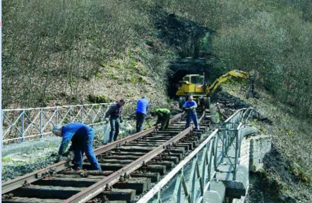
Le 25 mars 2007, l'équipe de la ligne 128 s'affairait au remontage de la voie entre le tunnel et la gare de Purnode. Christian AUQUIERE.
