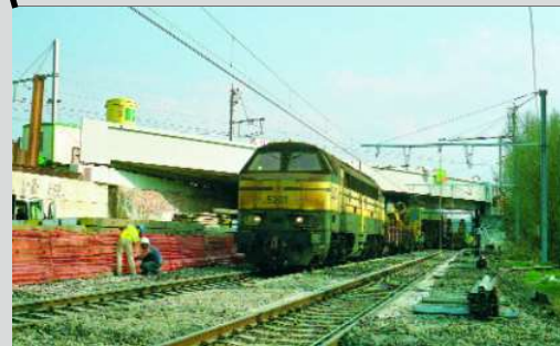
Un train de travaux opère sur la voie vers Namur, à Watermael. Le nouveau pont de la ligne 26 est en place. Le futur point d'arrêt "Arcades" sera situé partiellement sur le pont. Christian DOSOGNE, 9 avril 2007.
