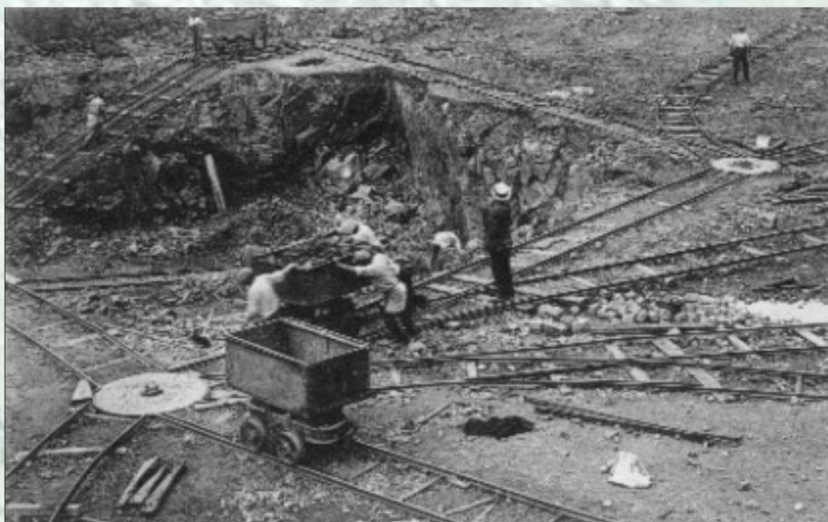
*Cette vue réalisée au fond d'une carrière, au pied d'un nouveau front de taille, nous permet de bien voir l'ensemble des voies Decauville, les plaques tournantes et aiguillages assurant la dispersion vers les postes de chargement. A gauche, un petit plan incliné permet de hisser les wagonnets à l'aide d'un treuil. CP Hanon, collection M. DUHAUT.*
