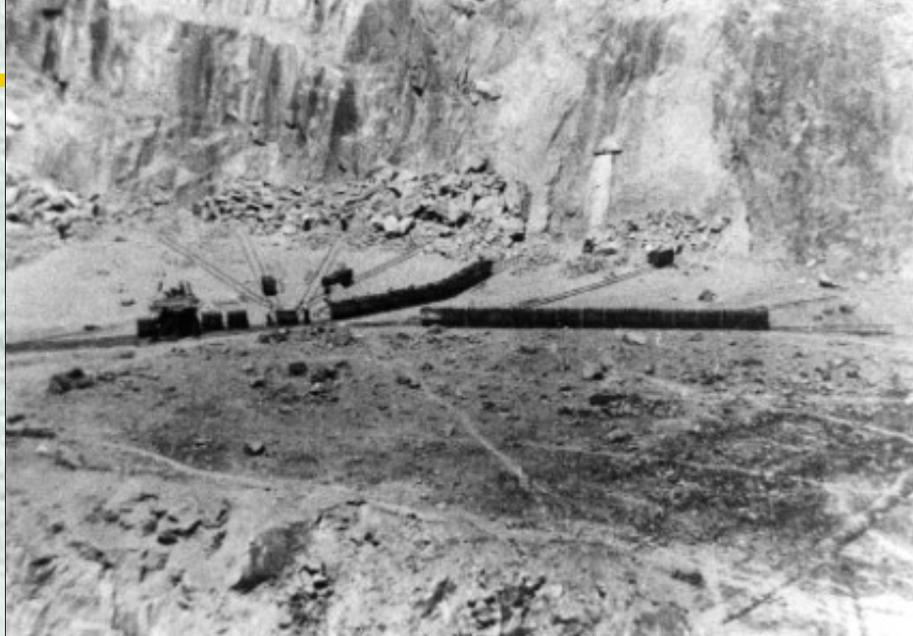
*Ces deux vues montrent le fond de la carrière Tacquenier et Cosyns et permettent de voir les nombreuses voies mobiles se dispersant en éventail le long du front d'exploitation, utilisées pour évacuer les pierres vers les appareils de remontées et les chantiers de production. La vue du bas a été réalisée vers 1920. Collection Michel DUHAUT.*
