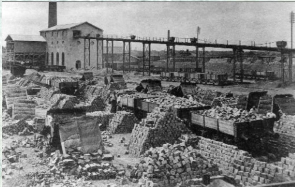
***A la carrière Tacquenier, le chantier d'épénçage (taille de pavés) et le chargement des pavés dans des wagons appartenant à la carrière. Les pavés sont mis en tas en fonction de leurs dimensions et de leur qualité. Dans le fond, on voit la rampe d'accès au concasseur et les wagonnets traînés par chaîne remontant du fond de la carrière.***
