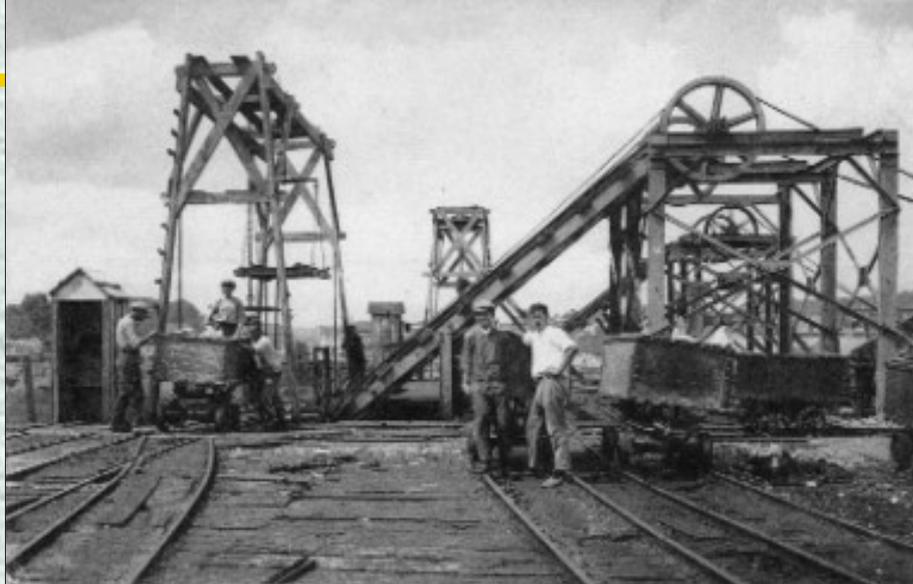
**La carrière Vandevelde possédait deux plans inclinés à chariots porteurs à voie transversale unique. Deux passerelles reliées par un système de chaîne et de poulies permettaient d'assurer la continuité de la voie en comblant le vide laissé par le chariot se trouvant en bas. Une de ces passerelles est suspendue au treuil visible à gauche.**
