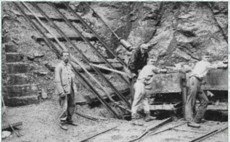
*Le plan incliné de la carrière Brassart était muni de deux voies transversales. Le câble tracteur est visible entre les rails. Ce câble plat s'enroulait sur un tambour de grand diamètre de la machine motrice. Les wagonnets sont poussés sur le bac de l'ascenseur.* Collection Michel DUHAUT.
