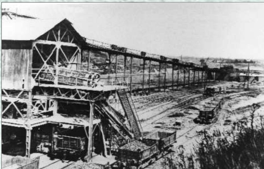
**Le concasseur de la carrière Tacquenier. Les wagonnets venant du fond de la carrière et amenés par chaîne, arrivent dans l'installation. A l'avant-plan, on voit deux wagons-bennes récupérant les déchets. Des wagons Etat Belge sont en cours de chargement.**
