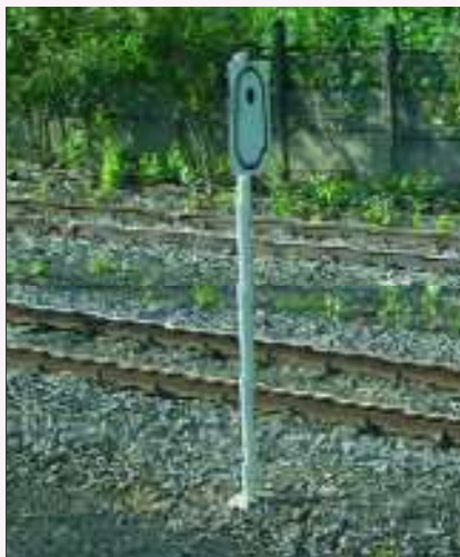
Un panneau de premier départ est implanté à Marbehan, au début de la ligne locale vers Croix-Rouge (ligne 155). Un mouvement se dirigeant sur la ligne circule à partir de ce panneau en grand mouvement régime de voie normale.
