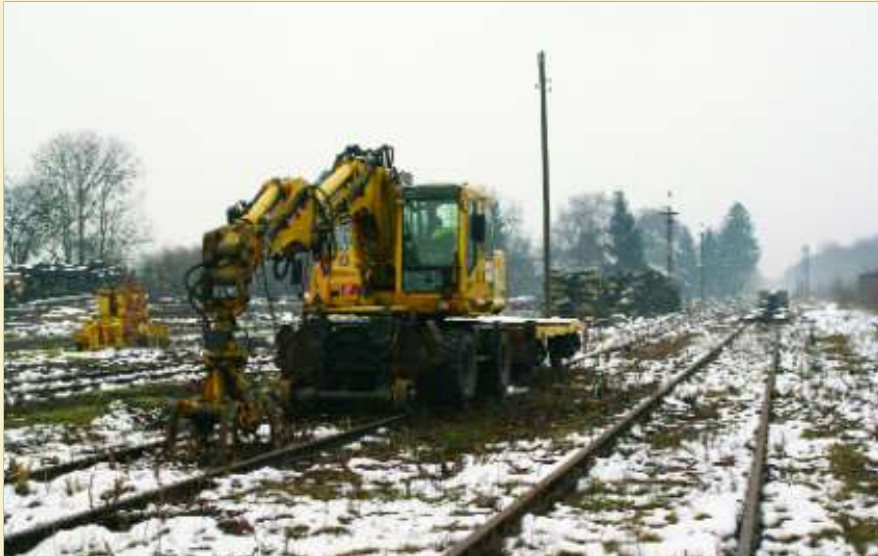
Les travaux de remise en état de la voie en gare de Raeren. Philippe GOUSSET, 25 novembre 2008.
