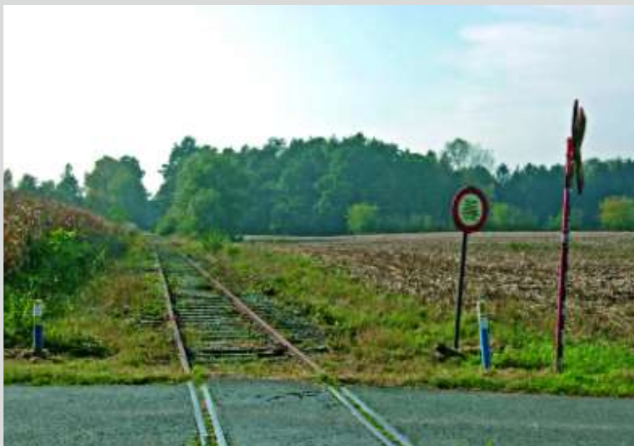
Un panneau de premier départ est implanté à Marbehan, au début de la ligne locale vers Croix-Rouge (ligne 155). Un mouvement se dirigeant sur la ligne circule à partir de ce panneau en grand mouvement régime de voie normale.
