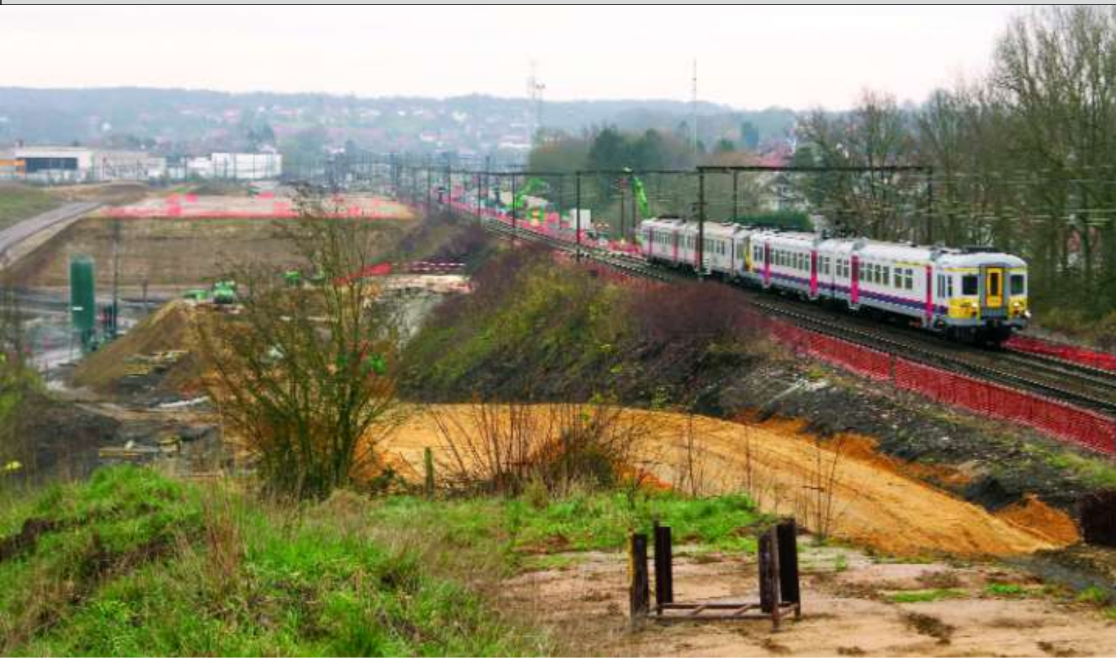
PHOTO 89-23 Nous voici à hauteur de l'ancien point d'arrêt de Limette-Buston. Dans le fond, on aperçoit les installations de la gare d'Ottignies. Deux automotrices modernisées assurent un CR à destination de Bruxelles. A gauche, le site délimité par des filets de chantier orange est celui sur lequel sera construit le futur poste d'entretien des automotrices RER. Limelette, 27 novembre 2008. Geert PACKET.
