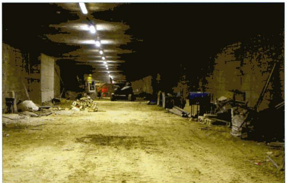
↑ Une partie du tunnel ferroviaire est déjà creusée.
