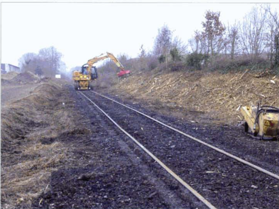
Du côté néerlandais, la rénovation de la ligne est pratiquement achevée; le passage de la frontière est fort bien visible. Ci-dessous, côté belge, les travaux n'en sont qu'à leur début. Une portion de voie de 200 m a été posée afin de permettre le déchargement d'un train de rail (photo du bas). Une grue procède au débroussaillage de ce court tronçon de ligne. Johny BRAUNS.
