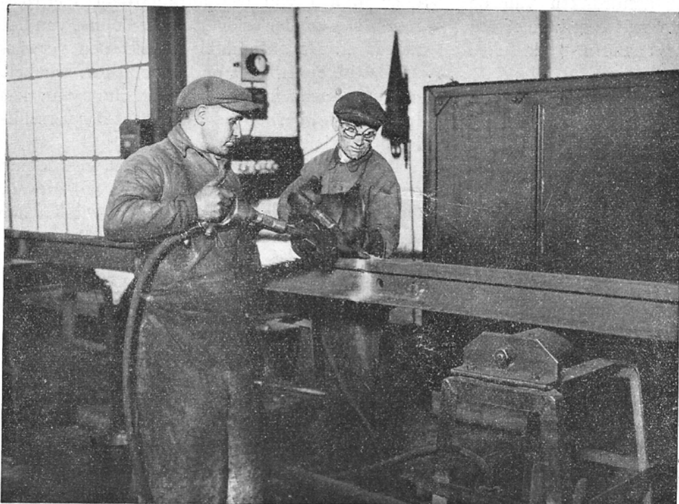
Afb. 2 - Onder profiel brengen van een lasch onmiddellijk na uitvoering.
