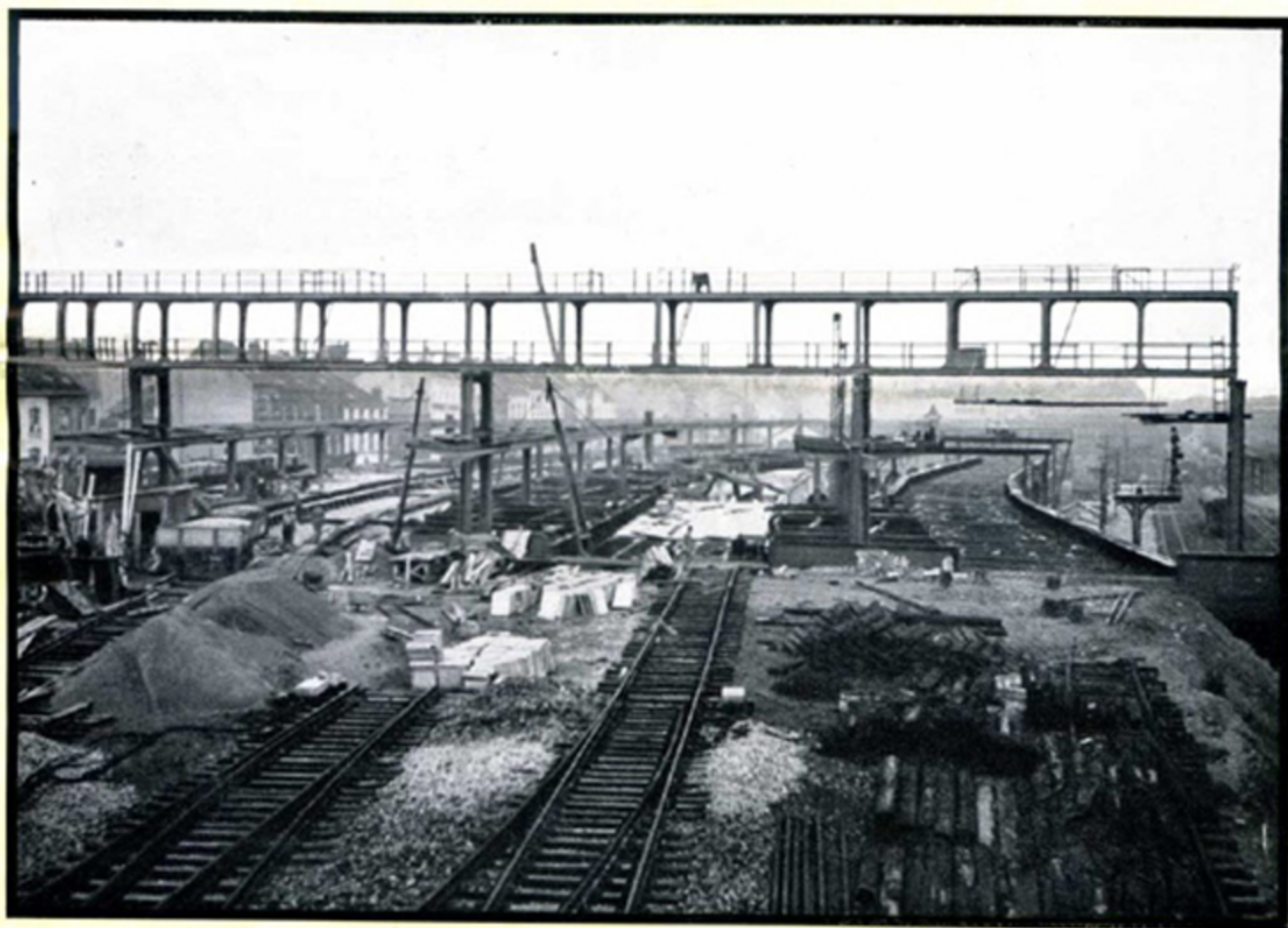
Les travaux de surélévation de la gare de Bruxelles-Midi
