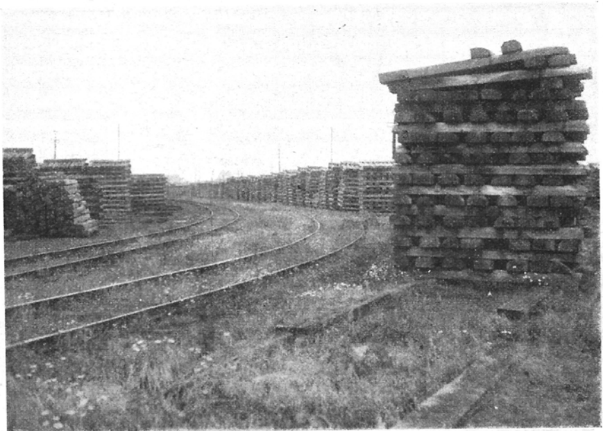
Dwarsliggers, geplaatst in open stapels
