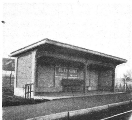
Schuilplaats type Blanmont, Cousteumont, Hamipré, Verlaine. op de stopplaatsen.
