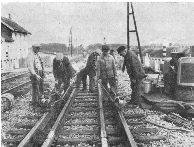
Uittrekken van kraagschroeven met de machine
