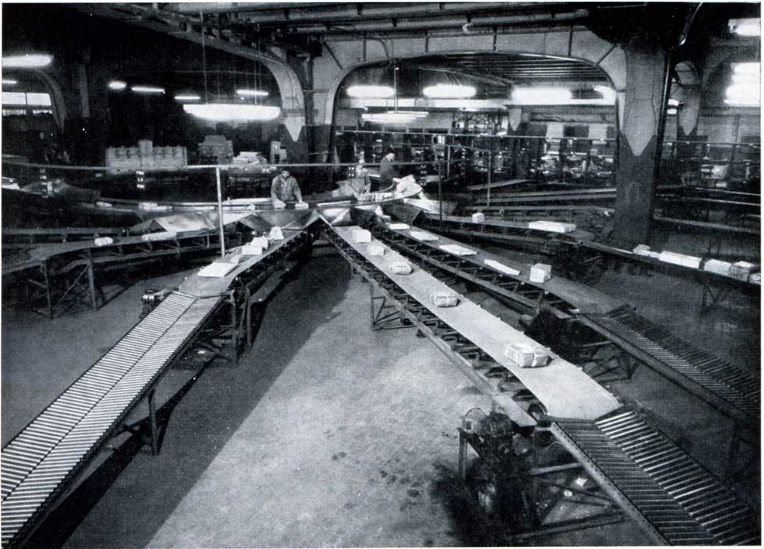
Installation mécanique de Bruxelles Midi pour la manutention et le tri des colis postaux.
